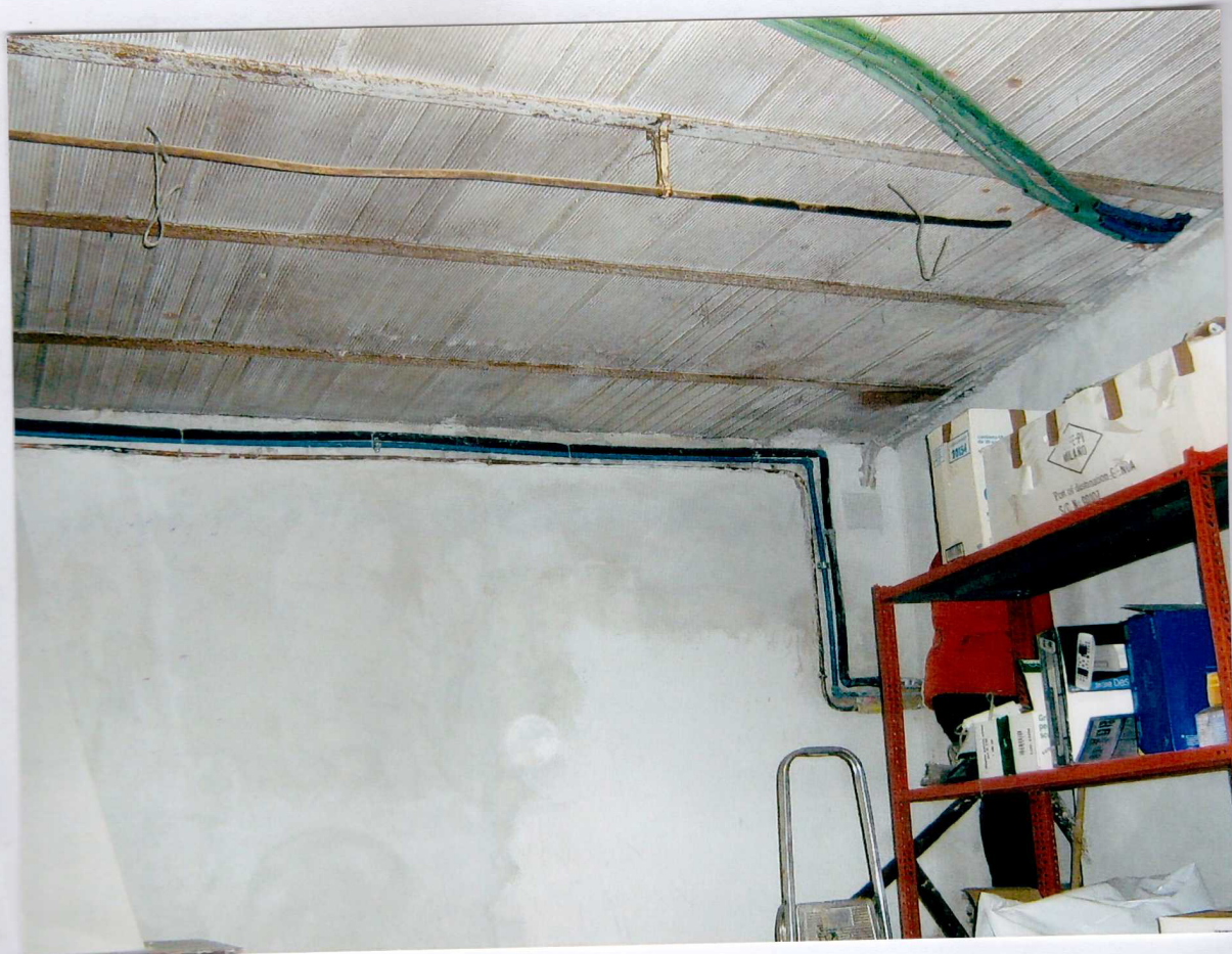
RIPRESE DALL'INTERNO PIANO TERRA
