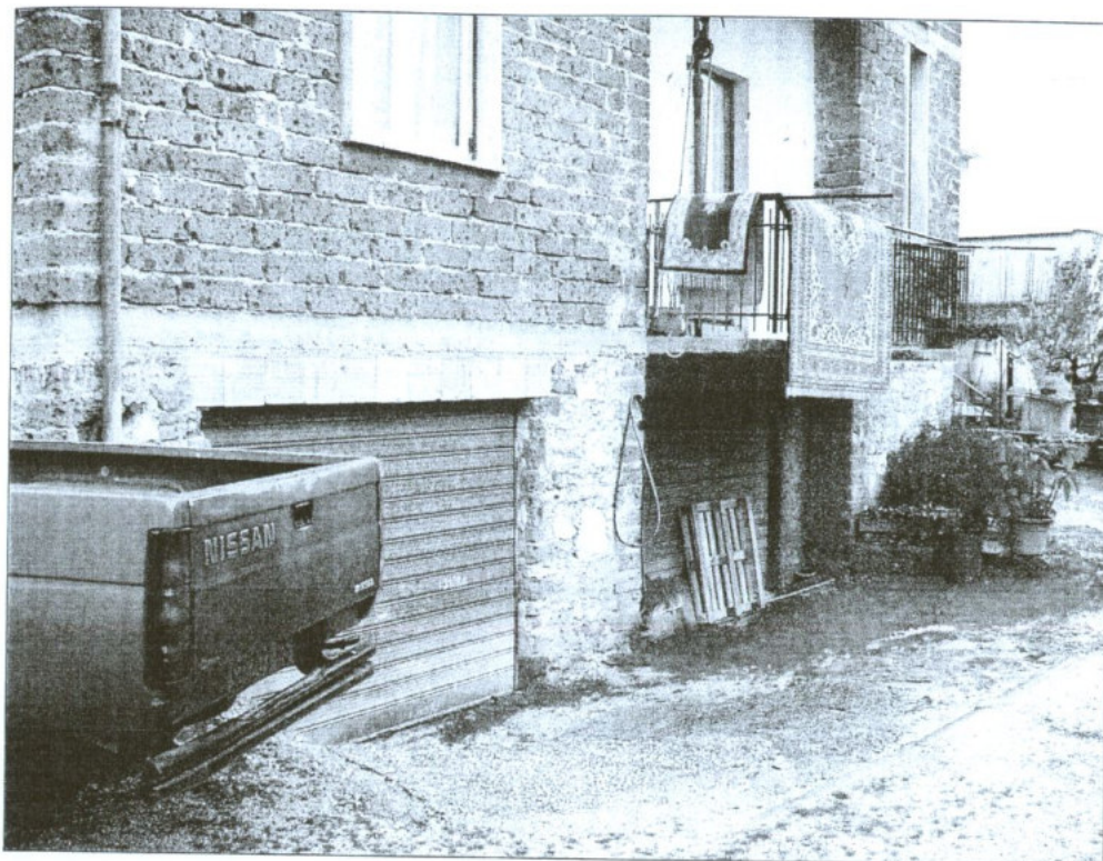
Facciata esterna lato garage
