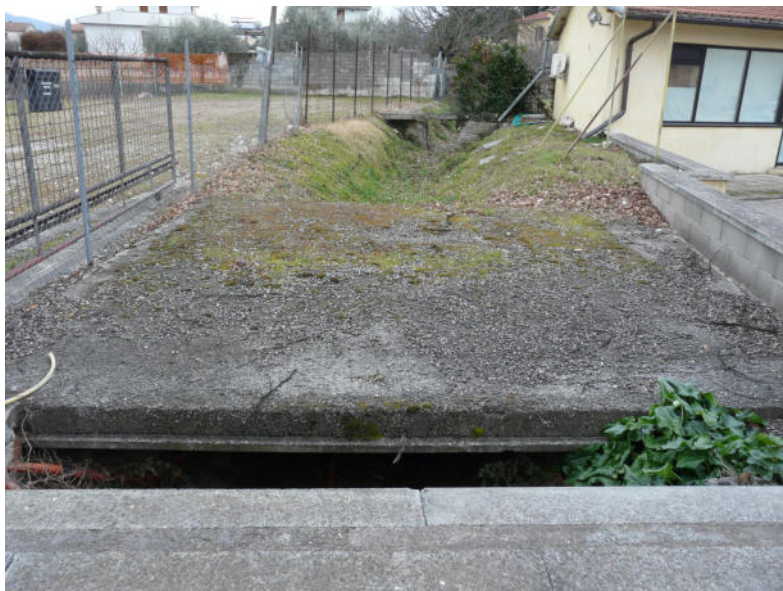
Foto 1.2 – vista dell'immobile 1 lato nord, particolare del fosso
