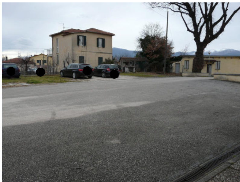
Foto 4.2 – Immobile 4: Vista vero est
