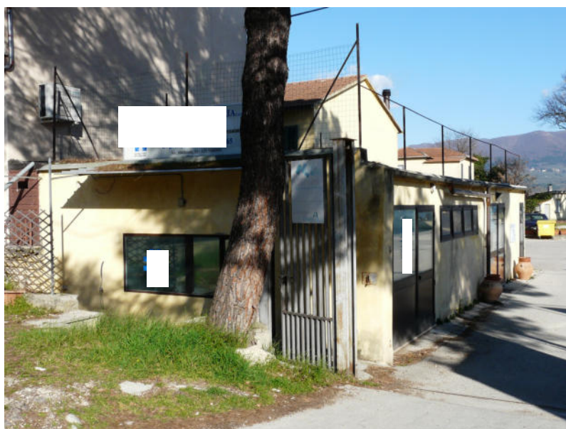
Foto 3.2 – Immobile 3: vista dalla strada
