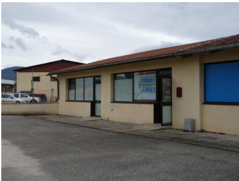
Foto 1.1 – Vista dell'immobile 1, verso il piazzale
