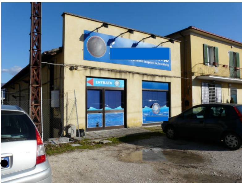
Foto 2.6 - Immobile 2: vista dalla strada
