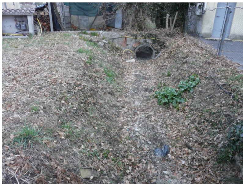
Foto 4.4 – Immobile 4: Particolare del fosso sul confine ovest
