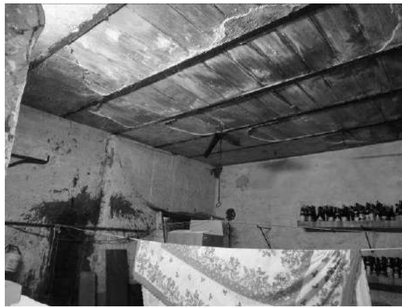
Vista interna della cantina
