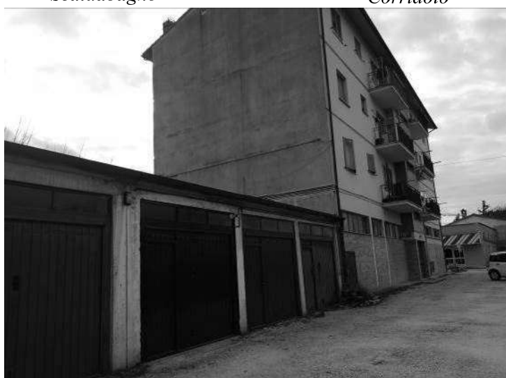
Esterno con vista garage
