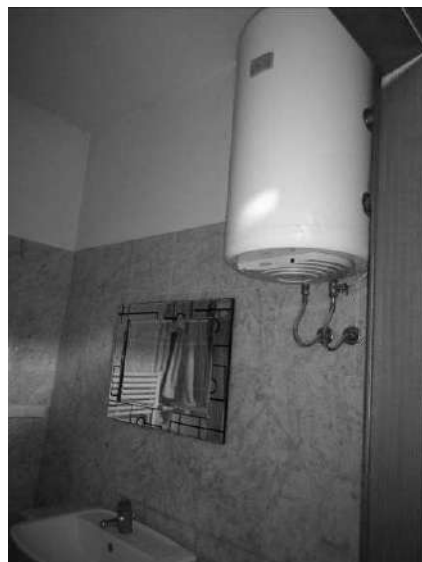
Servizio igienico (scaldabagno)
