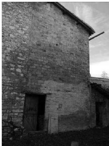
Esterno cantina: ingresso
