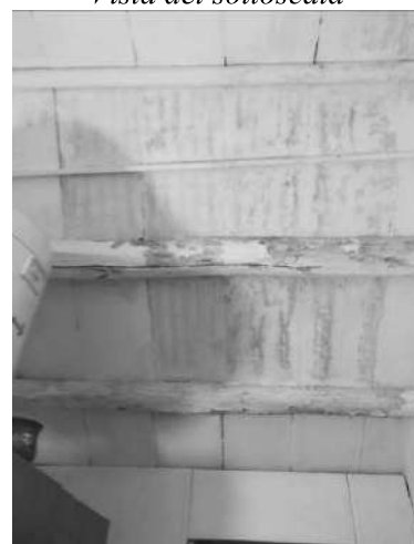
Vista del solaio della scala
