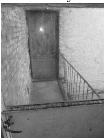
P.1°: Balcone – ingr. soffitta
