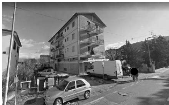
Prospetto su via Carlo Marx
