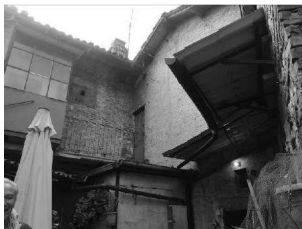
Viste del cortile interno
