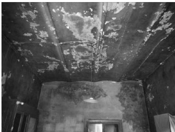
Cucina: vista del solaio a voltine
