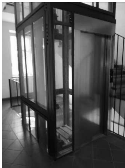
Vano scala - ascensore
