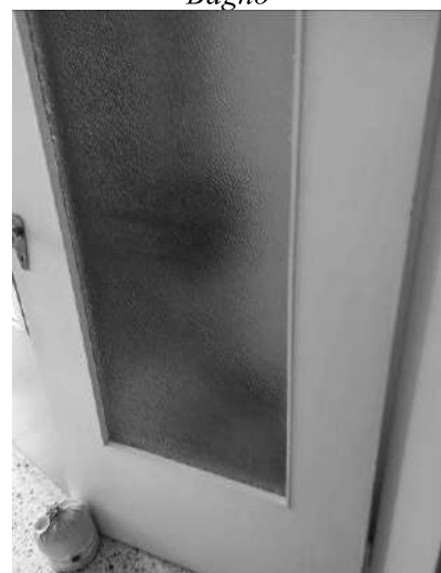
Particolare infisso interno
