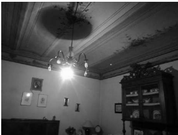
P.T.: Soggiorno – solaio a voltine dipinte
