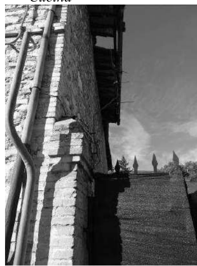
Vista dello sporto di gronda
