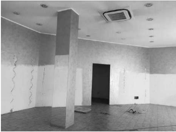
Locale di ingresso vista interna
