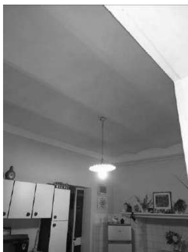
P.T.: Disimpegno retro
