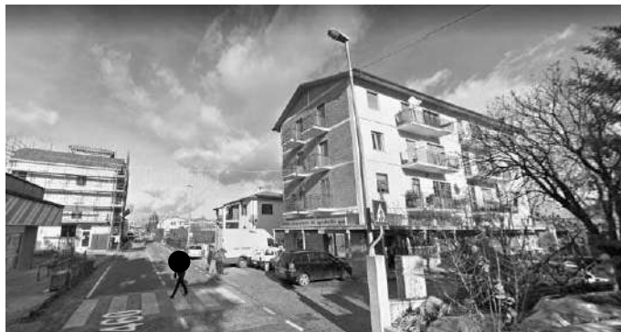
Prospetto su via Carlo Marx
