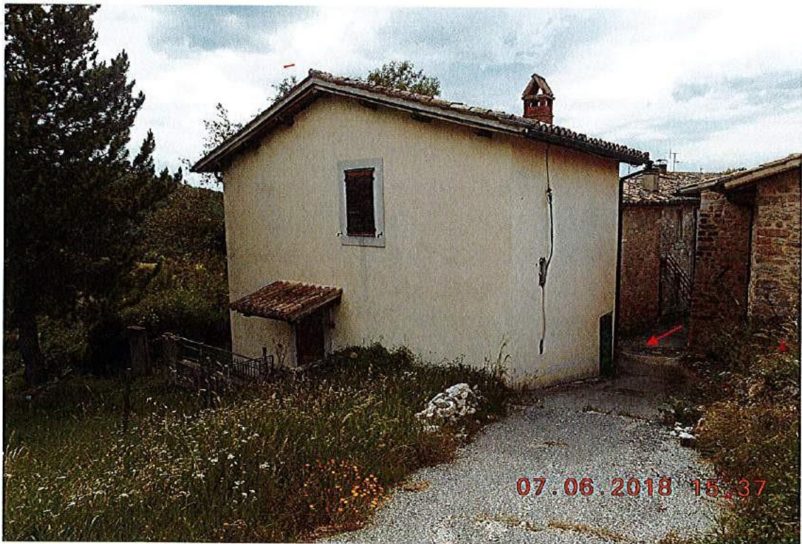
Vista complessiva fabbricato
