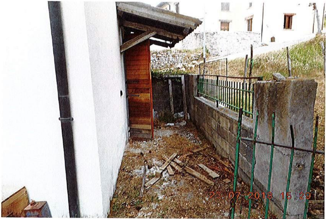
Particolare recinzione e corte
