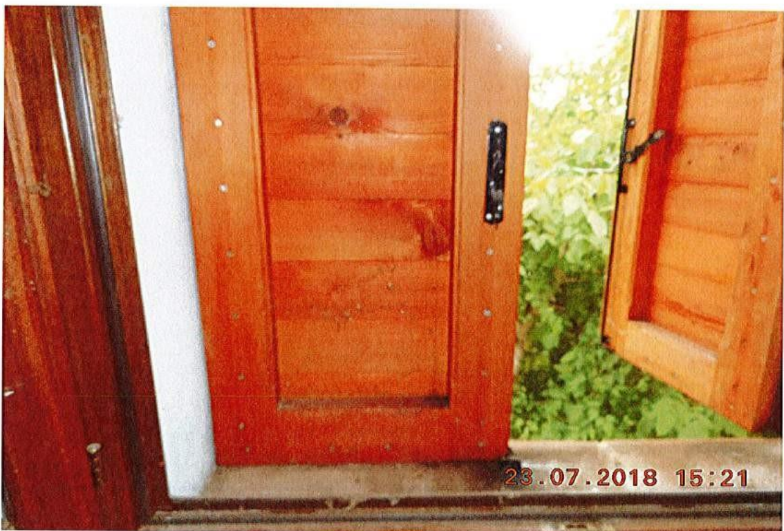
Particolare infissi esterni
