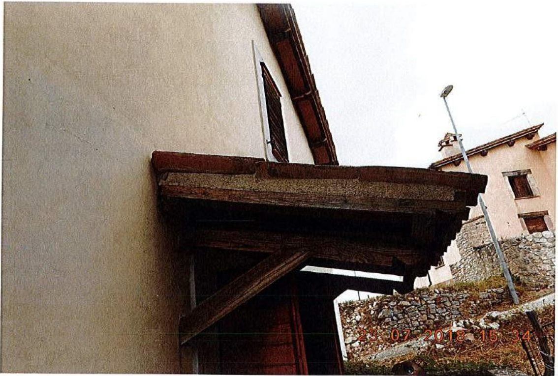
Particolare tettoia portoncino di ingresso
