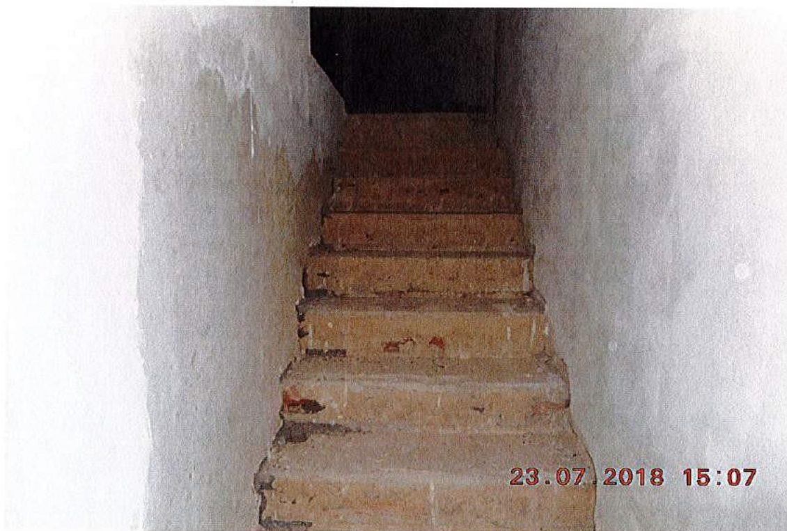
Scala accesso piano primo
