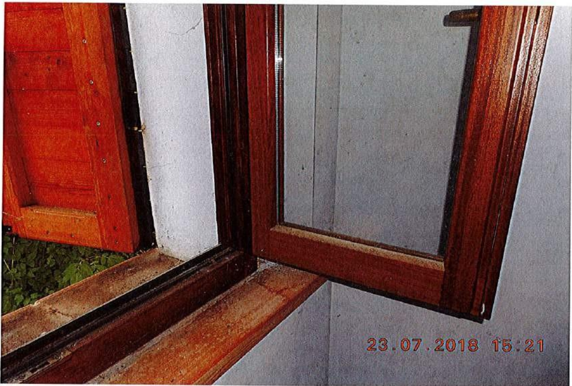
Particolare infissi esterni
