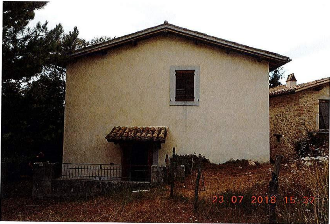
Vista fabbricato lato fronte
