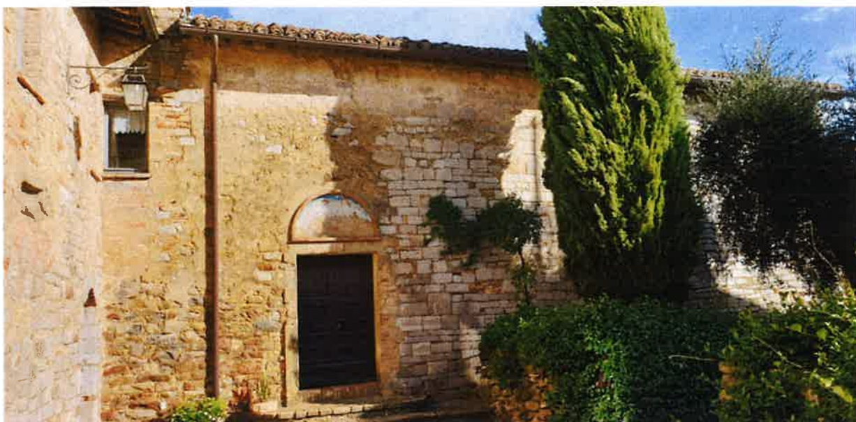
Foto n° 29: esterno della chiesa ( fg 93 part A )
