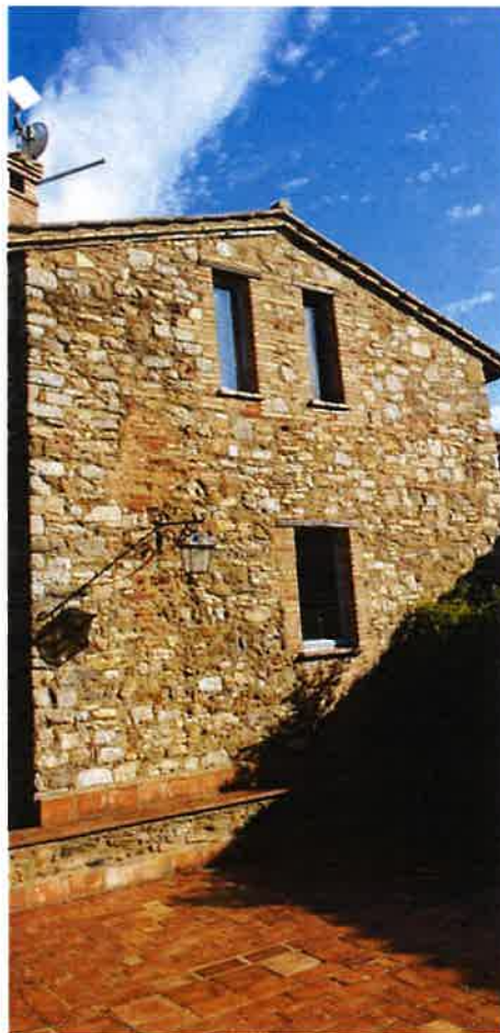
Foto n° 34: particolare dell'abitazione del custode ( Fg 93 part 196/2 )
