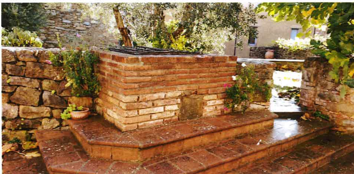
Foto n° 12: particolare della cisterna comune ( Fg 93 part 75 )
