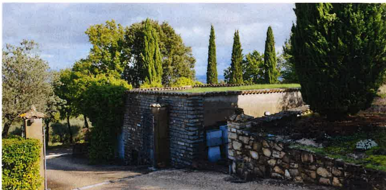
Foto n° 35: magazzino e vano depuratore acque nere ( fg 93 part 154/1 )
