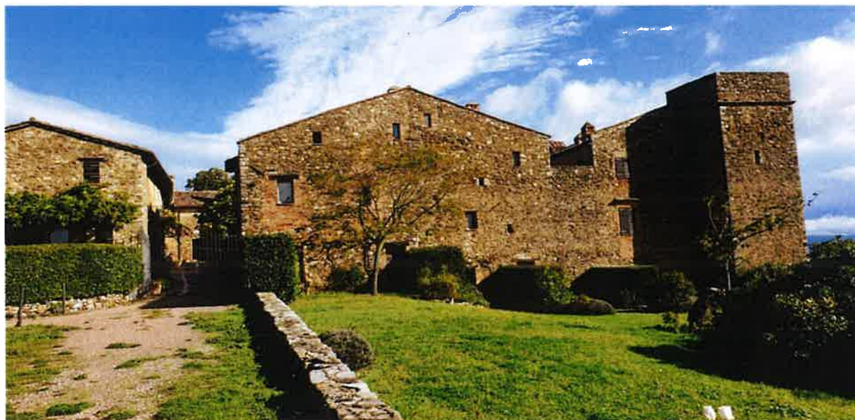
Foto n° 6: ingresso del Borgo di Montelagello lato sud
