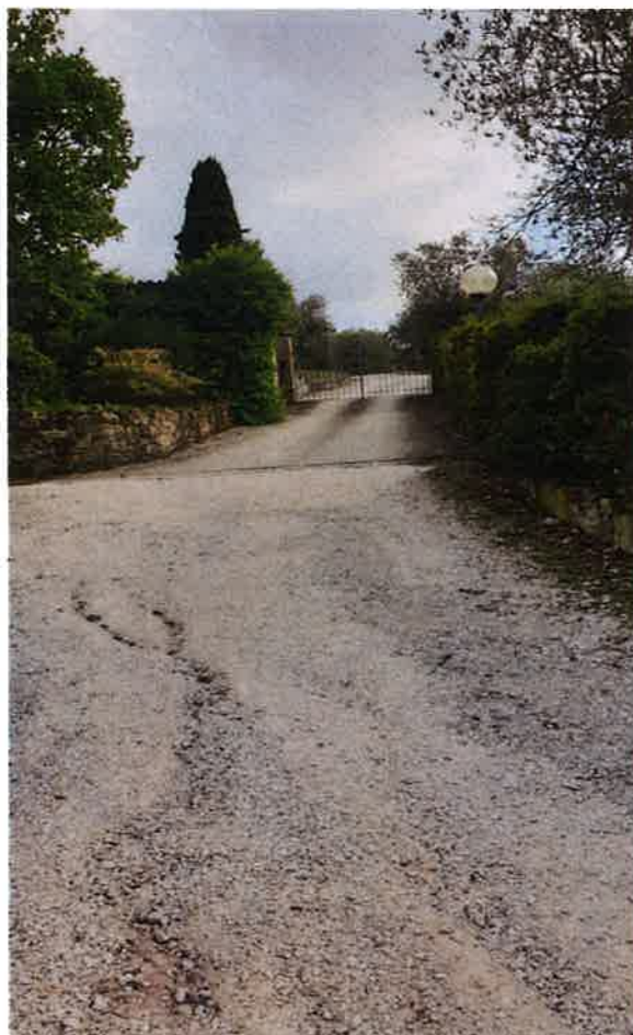
Foto n° 4: strada di accesso con cancello
