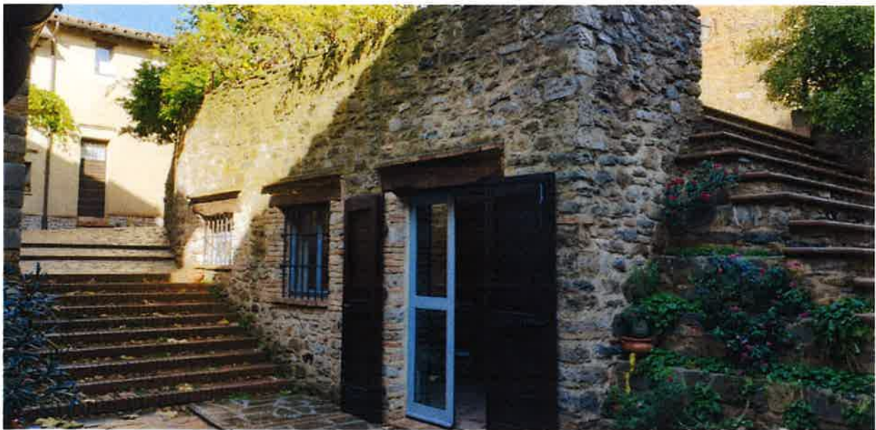
Foto n° 33: particolare dell'ingresso sala condominiale ( Fg 93 part 196/1 )
