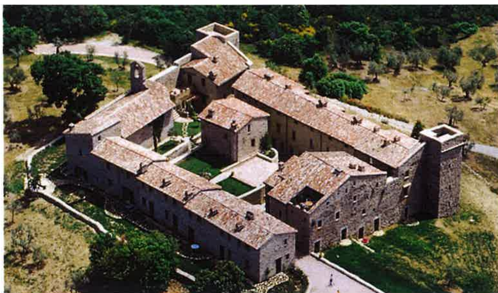
Borgo di Montelagello dopo la ristrutturazione
