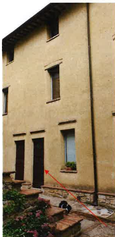
Foto n° 15: porta d'ingresso dell'abitazione
