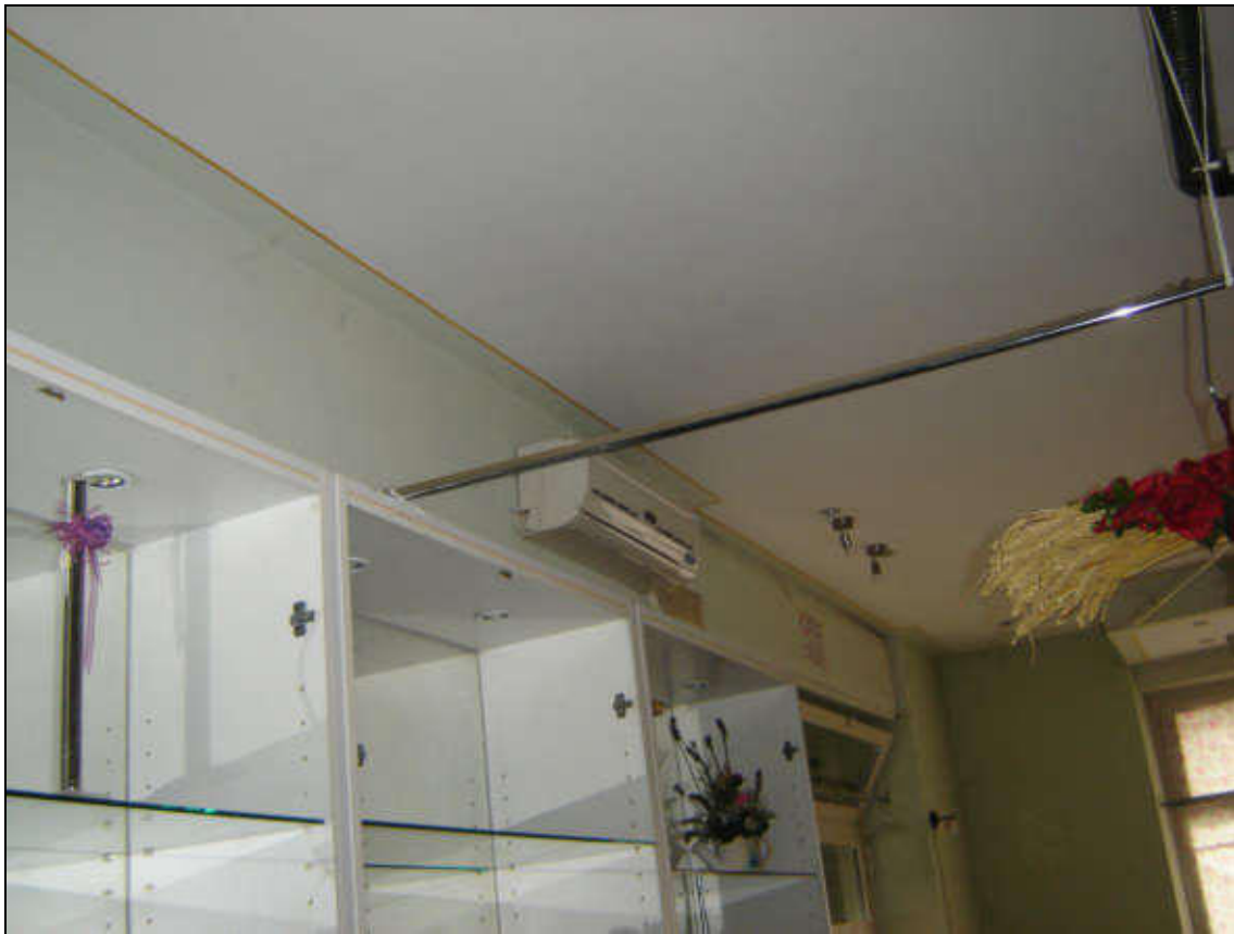
Foto 10 : vista interno - controsoffitto
