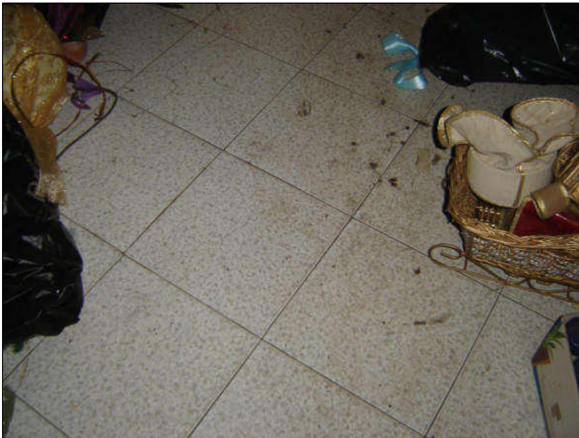
Foto 11 : vista interno - pavimentazione
