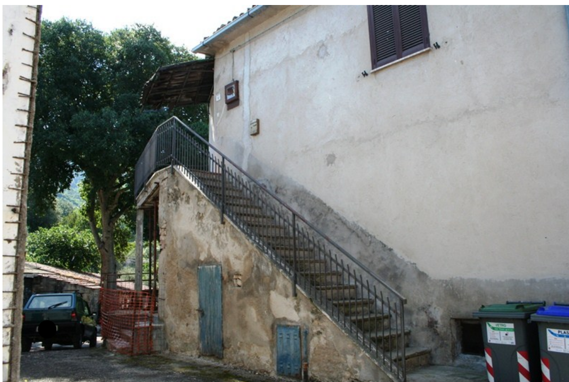
FOTO N° 2 Vista esterna del complesso edilizio
