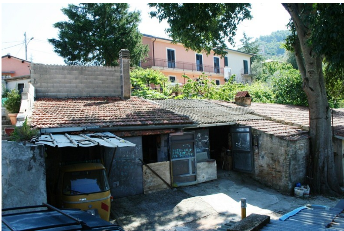
FOTO N° 18 Vista esterna – Corte esclusiva – garage e Tettoia U.I. 2
