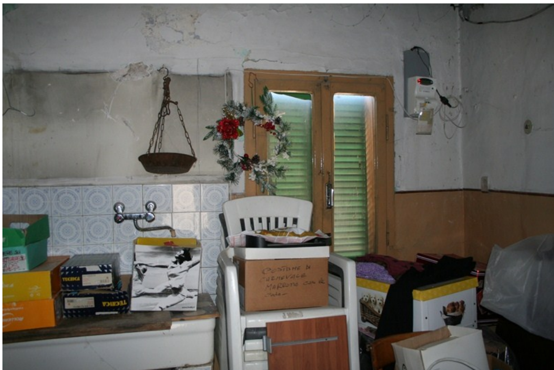
FOTO N° 16 Vista interna – U.I. 2 – cucina P.1
