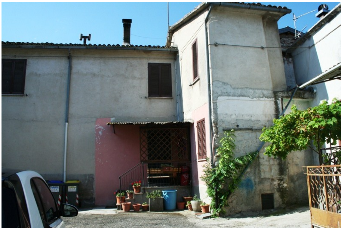
FOTO N° 1 Vista esterna - Ingresso Unità Immobiliare n. 1
