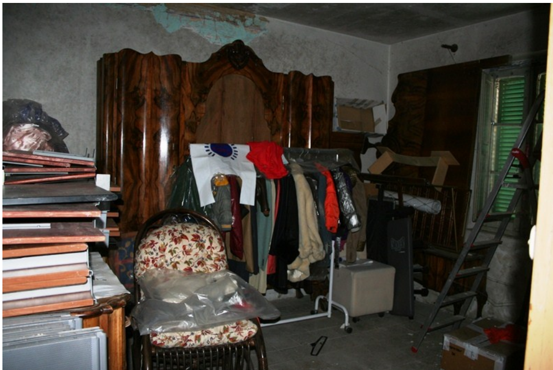
FOTO N° 13 Vista interna – U.I. 3 – Camera
