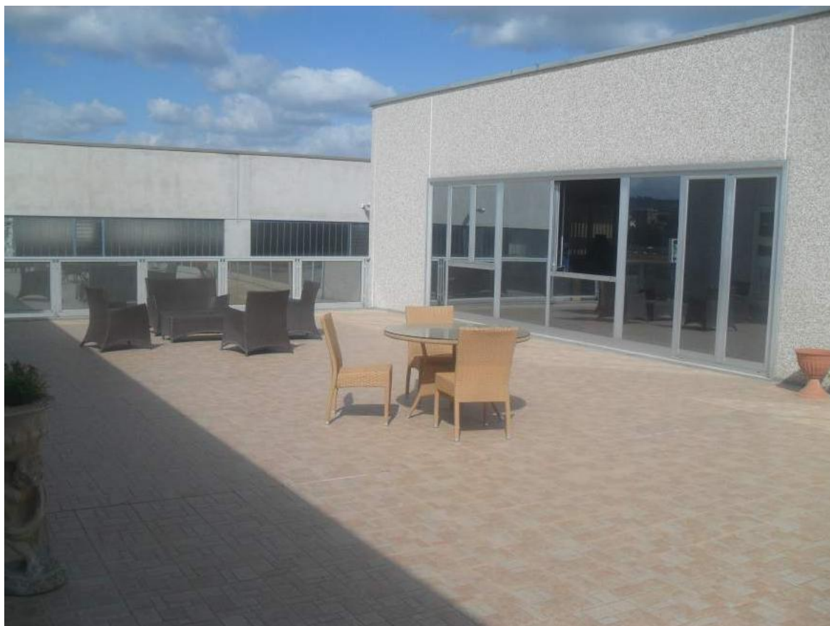
Foto n. 32 –Altra vista del terrazzo comune posto tra i locali del lotto “C” e del lotto “D”
