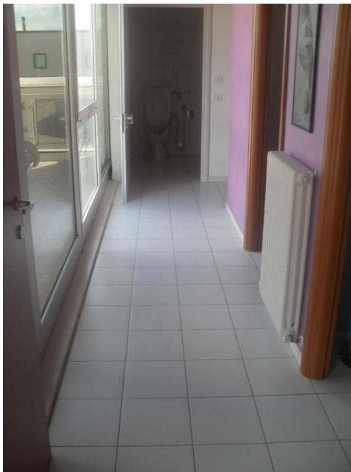
Foto n. 29 –Vista zona disimpegno con ingressi spogliatoi e bagni (di cui al n. 27 elaborati grafici)
