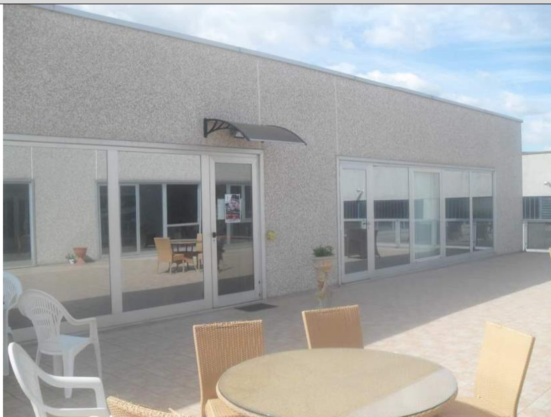
Foto n. 23 –Vista esterna sul terrazzo comune dell'ingresso dell'attività
