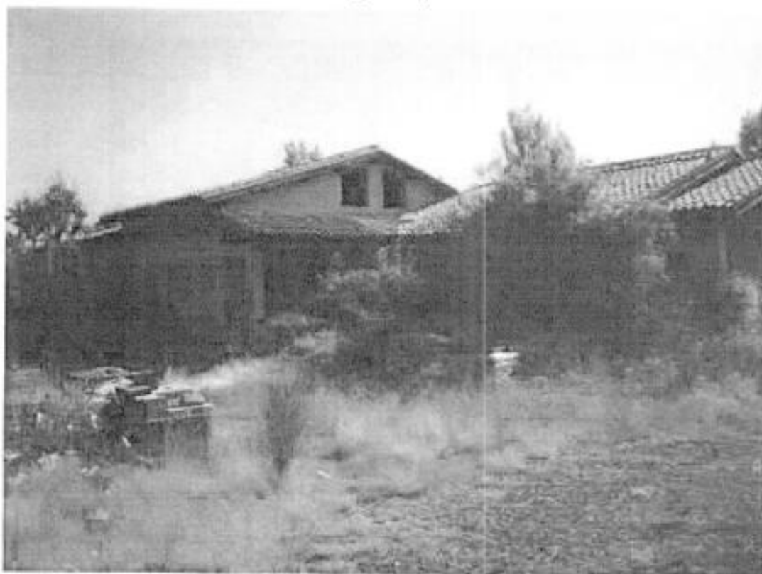
Foto n° 18: prospetto frontale/laterale sinistro dell'edificio n°2 ( si nota la vegetazione infestante e l'accumulo di materiali edilizi )
