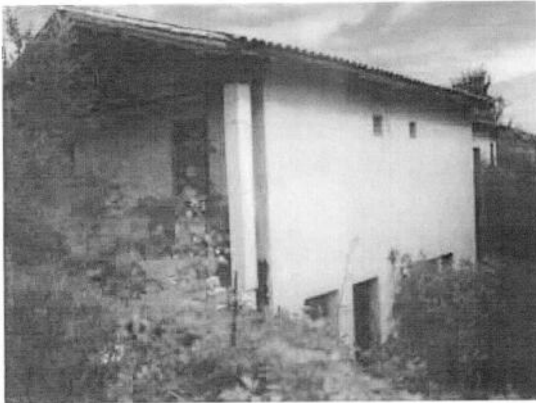
Foto n°19 : prospetto frontale/laterale destro dell'edificio n°2 ( si nota la vegetazione infestante e il completo intonaco finito a coltella delle pareti esterne )
