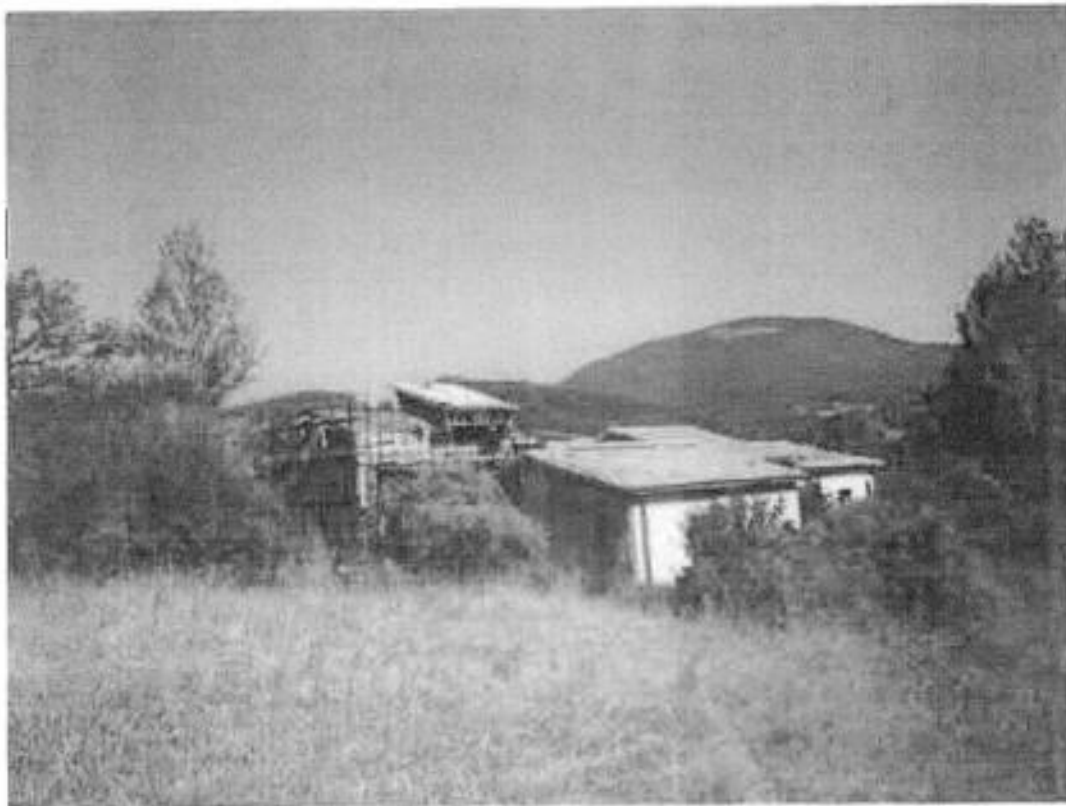
Foto n° 3: vista parziale dei due fabbricati in corso di costruzione
