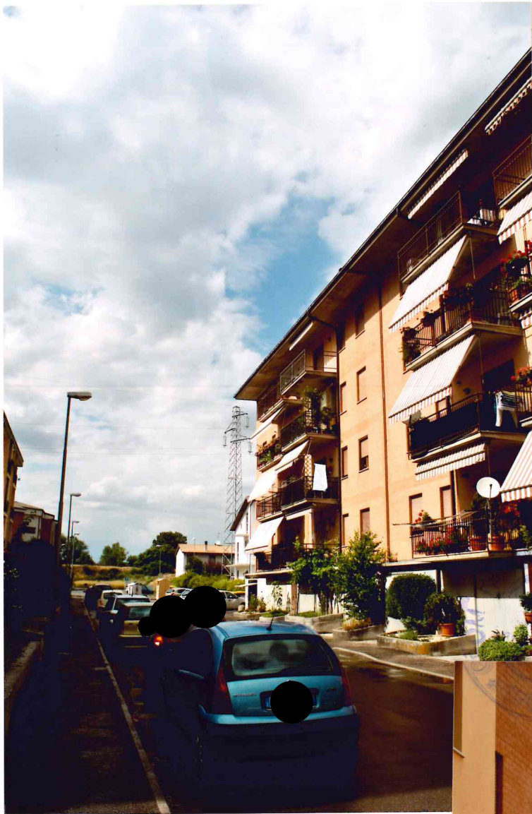
① PROSPETTO PAZZINA LATO OVEST
