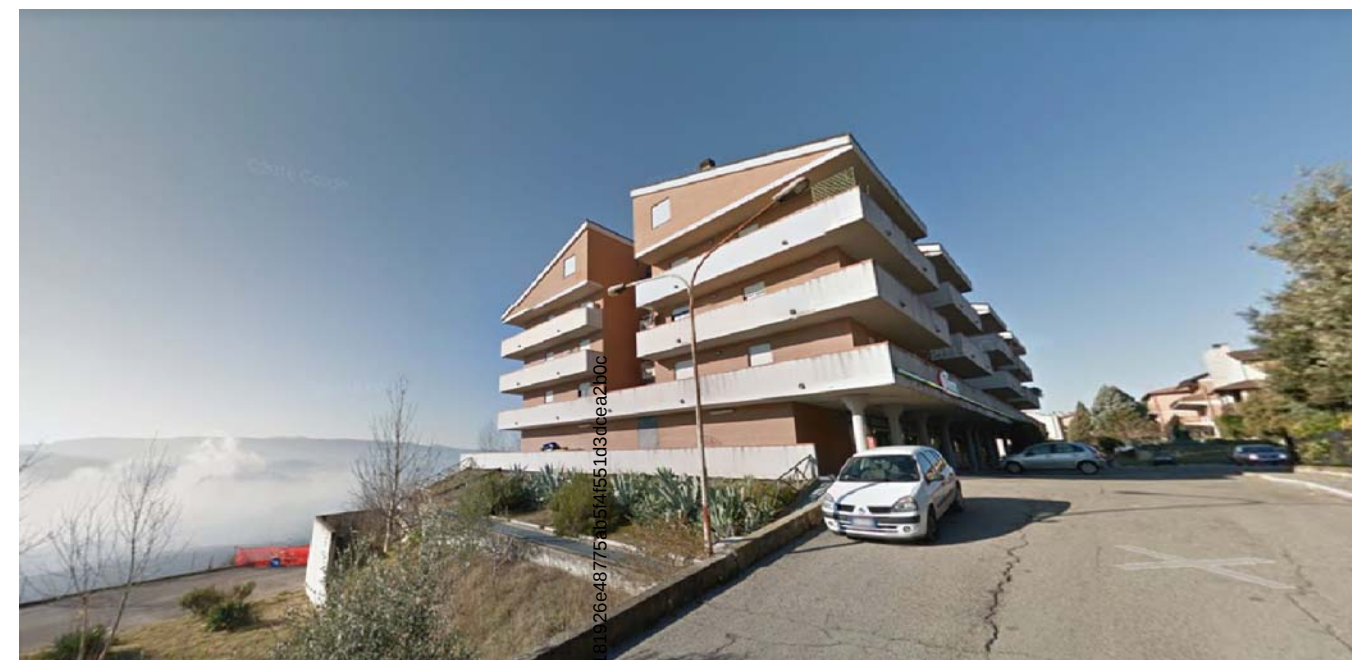
FOTO 4 - Vista Ovest del complesso immobiliare
