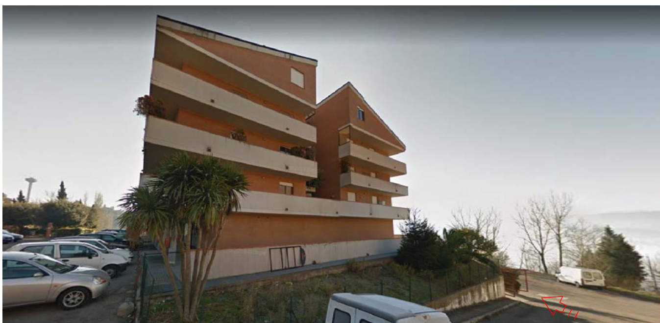
FOTO 5 - Vista Est del complesso immobiliare
