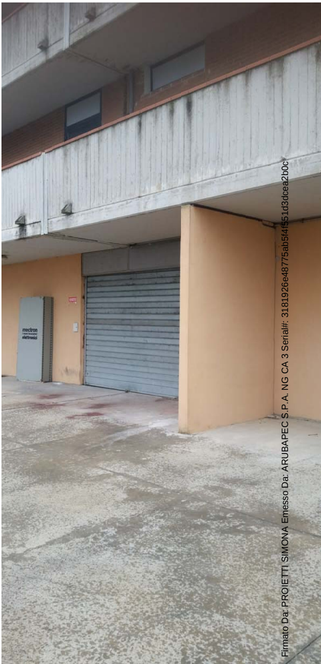
FOTO 10 - Vista esterna (sub.128)
