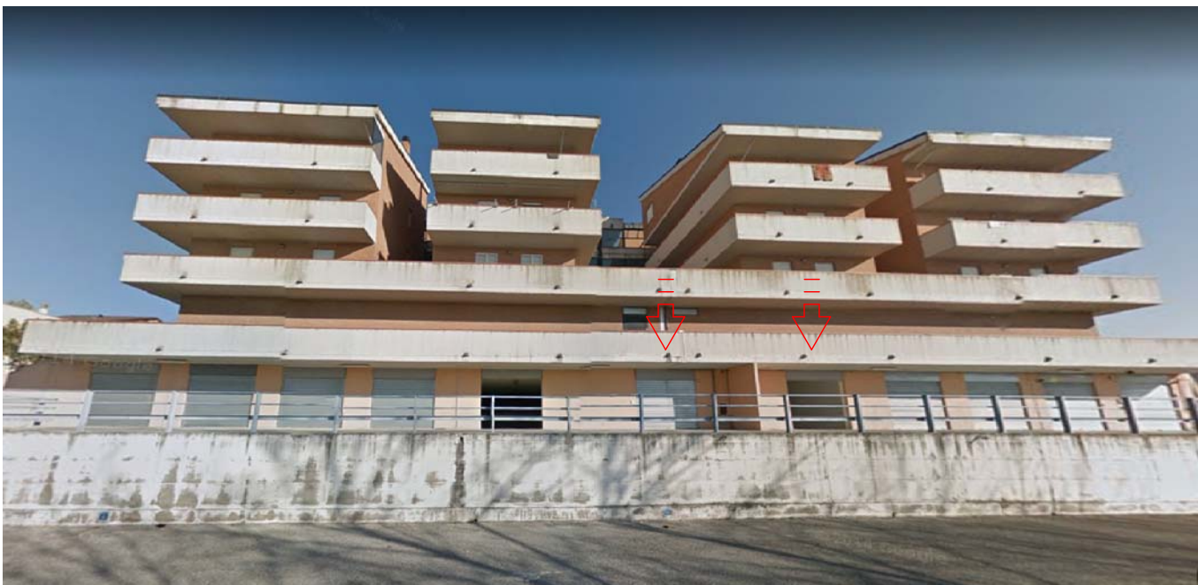
FOTO 8 - Vista dei magazzino e delle corsie di accesso ai box
