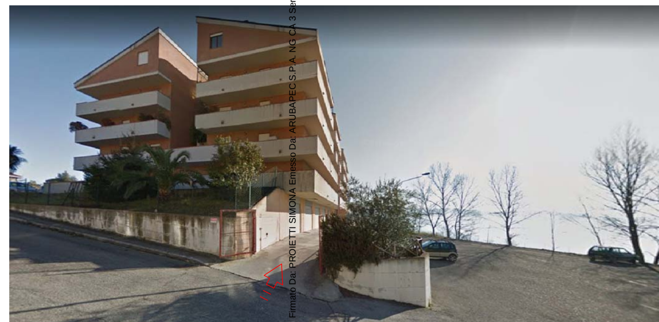
FOTO 6 - Vista accesso al piano seminterrato
