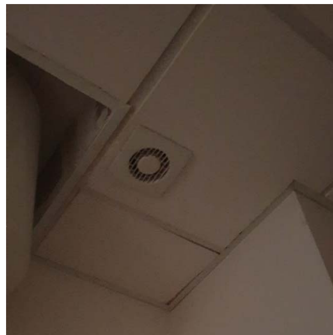
FOTO 29 - Vista di dettaglio
