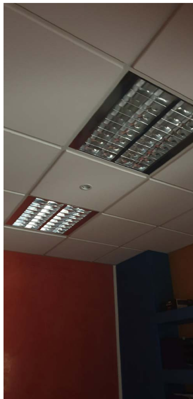
FOTO 21 - Vista del ripostiglio
