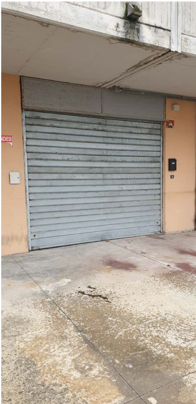
FOTO 11 - Vista esterna (sub.128)
