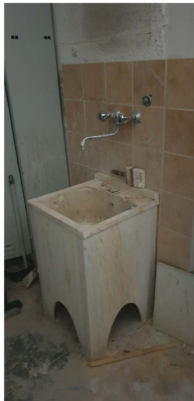
FOTO 33 - Vista di dettaglio
