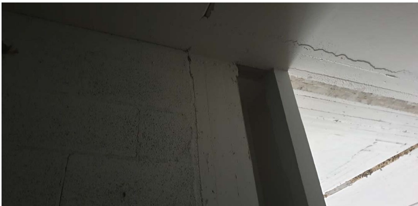
FOTO 31 - Vista di dettaglio lato bagno e superficie ex box
