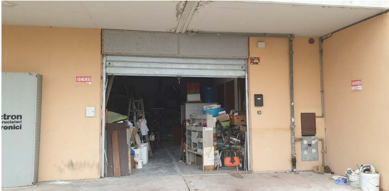
FOTO 10 - Vista del magazzino (sub.128)
