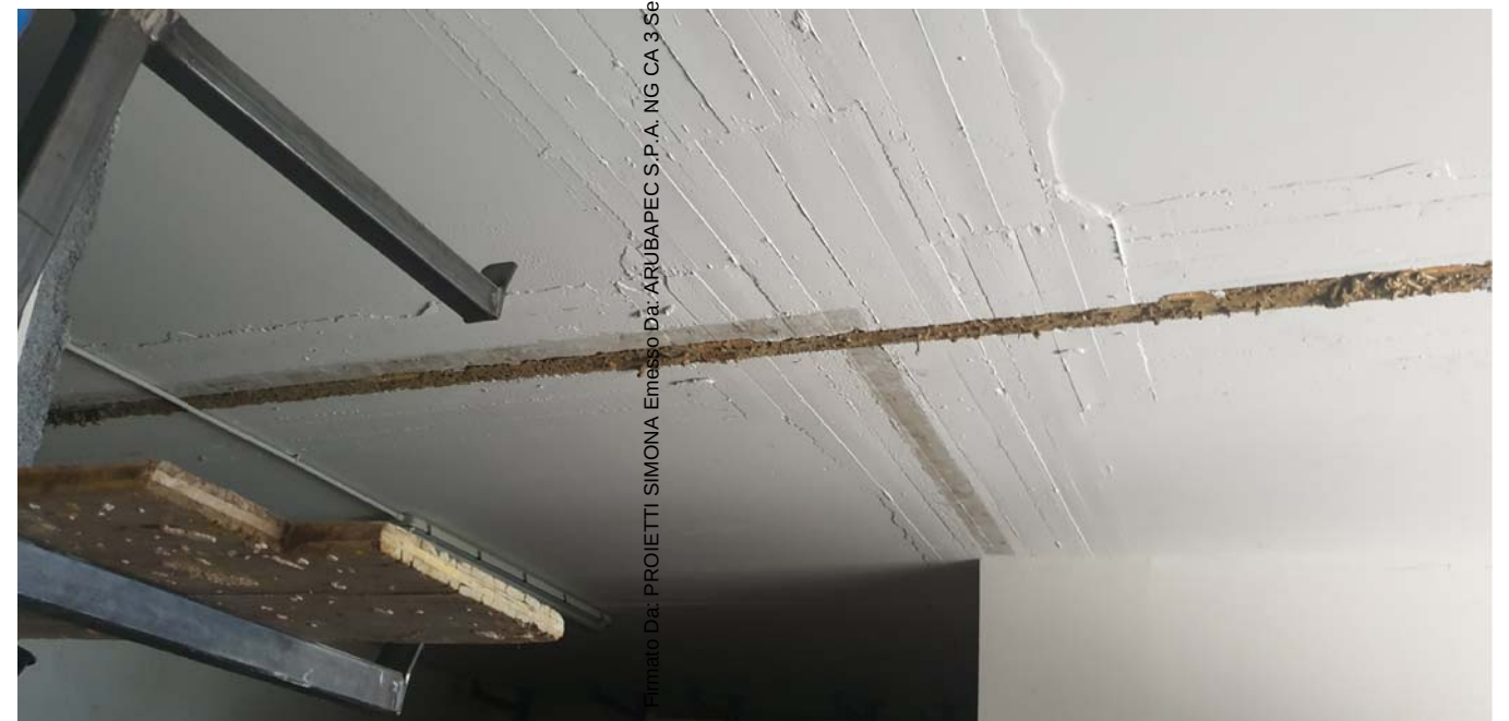
FOTO 30 - Vista di dettaglio lato bagno e superficie ex box
