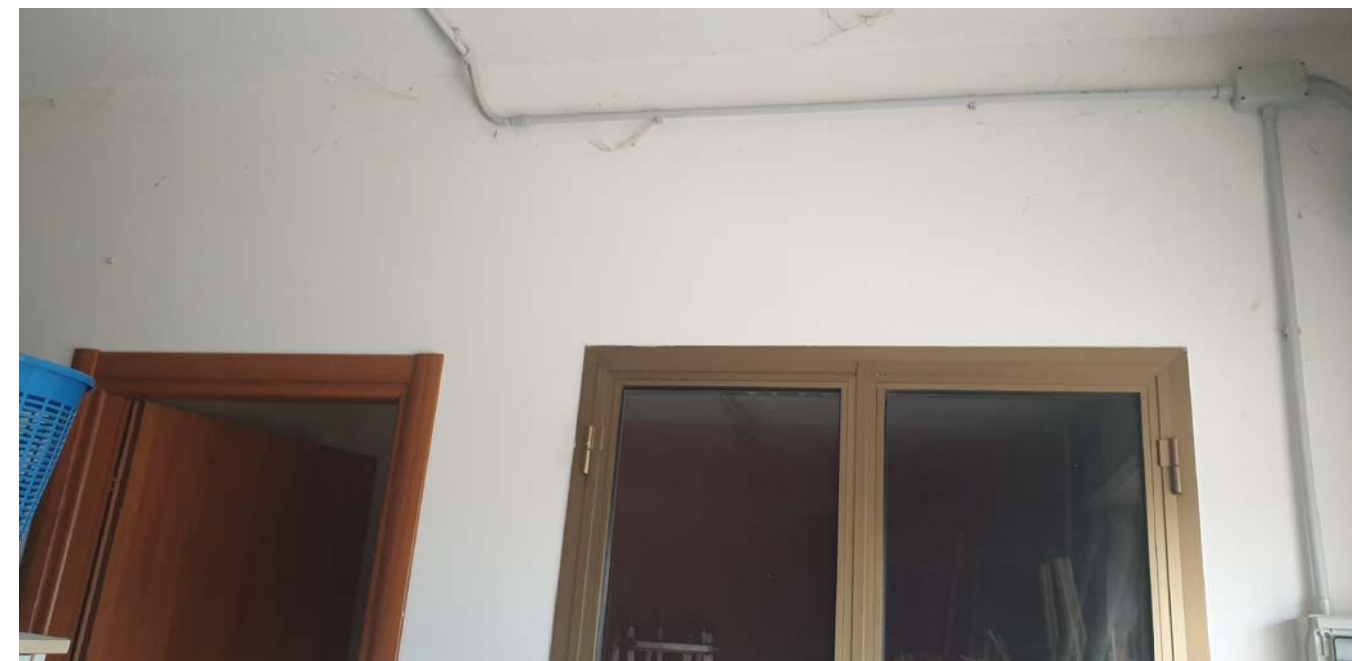
FOTO 19 - Vista di accesso ripostiglio (utilizzato attualmente come ufficio)
