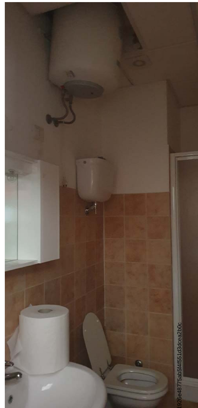
FOTO 26 - Vista del bagno
