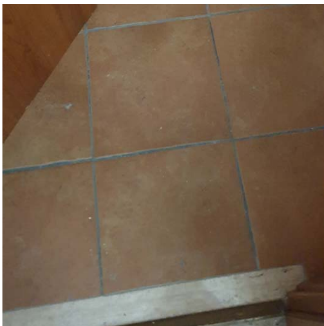
FOTO 28 - Vista di dettaglio
