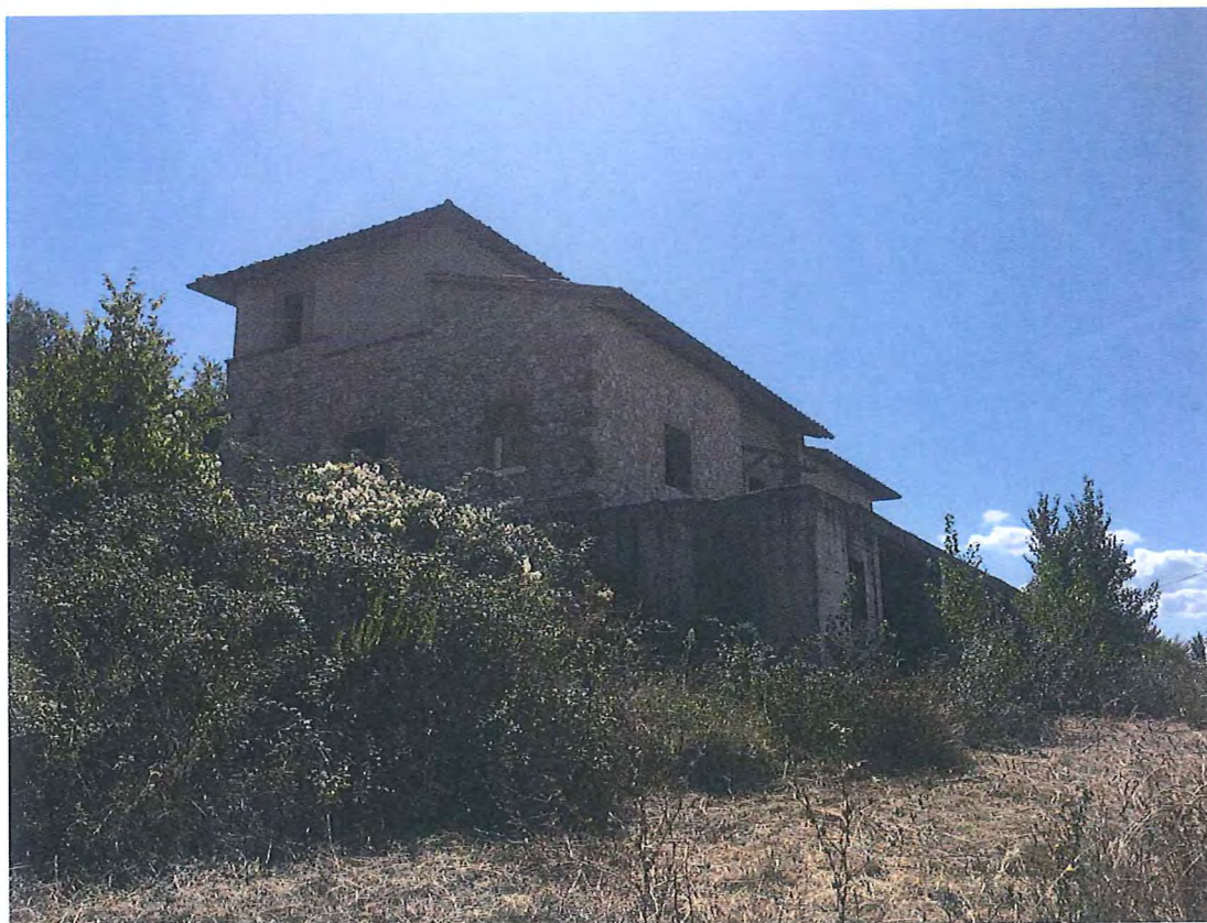
Foto n. 33 – Collazzone: terreno e fabbricato.
