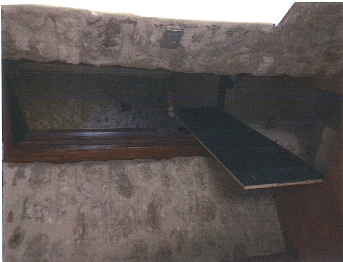
Foto n. 7 – Piano terra: botola di passaggio al piano interrato.
