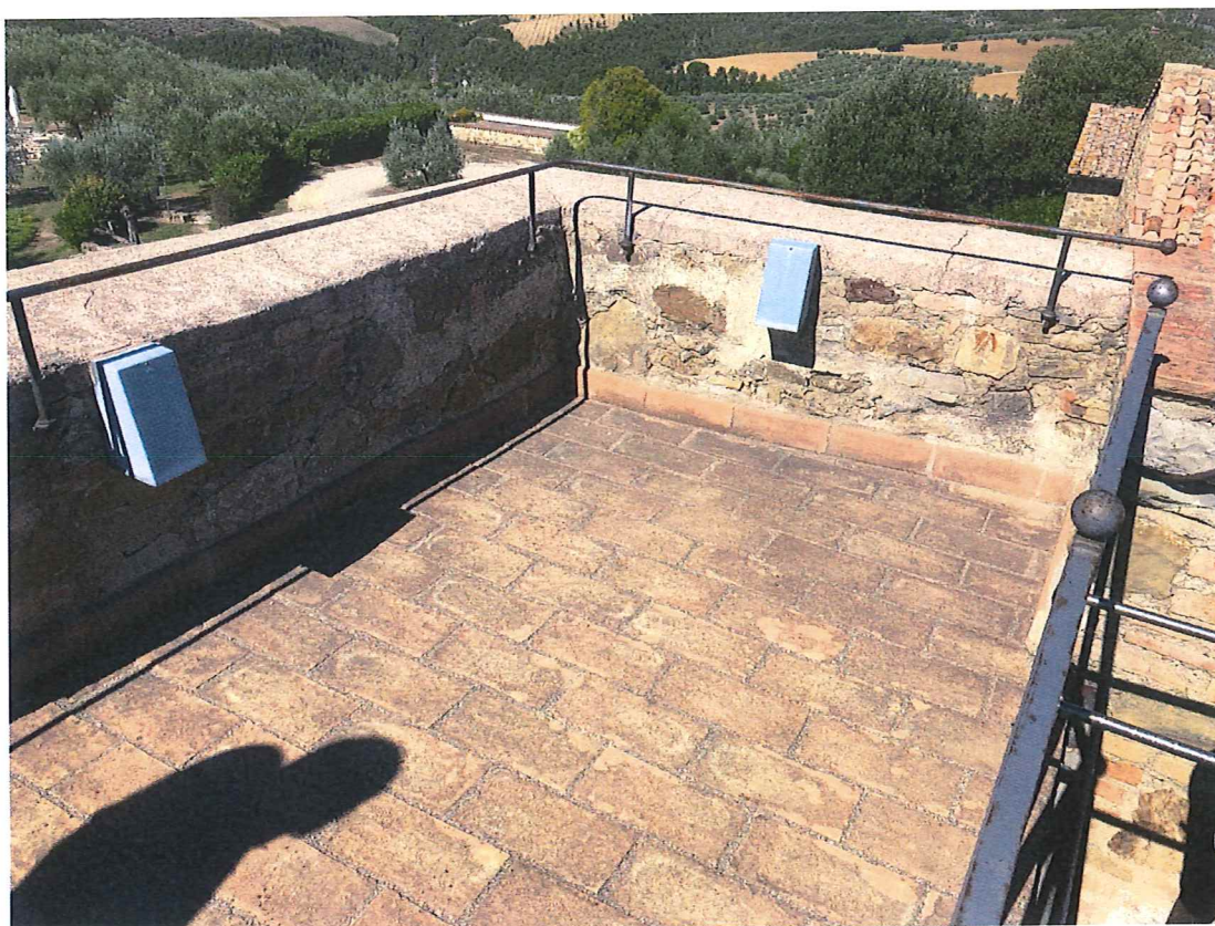
Foto n. 24 – Piano quarto: solarium.
