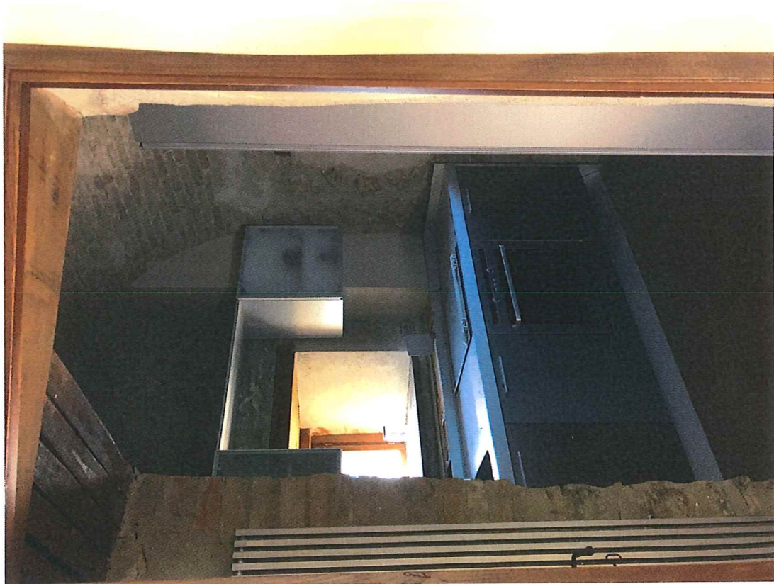
Foto n. 18 – Piano secondo: cucina (vano torre).
