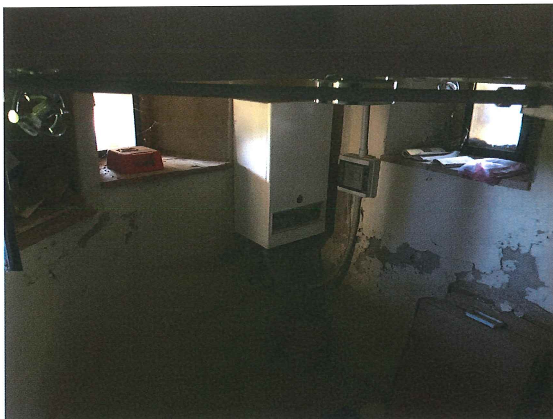
Foto n. 6 – Piano interrato: locale torre.
