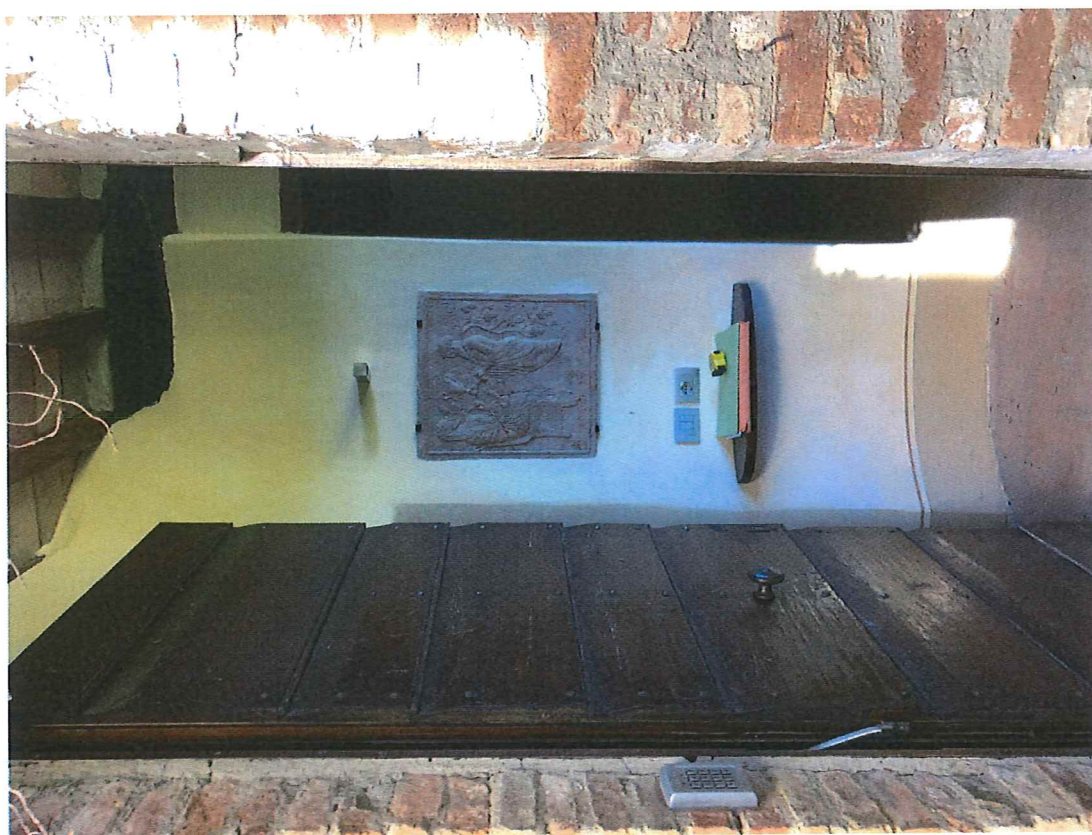
Foto n. 12 – Portone di ingresso da lato nord e appartamento piano primo.
