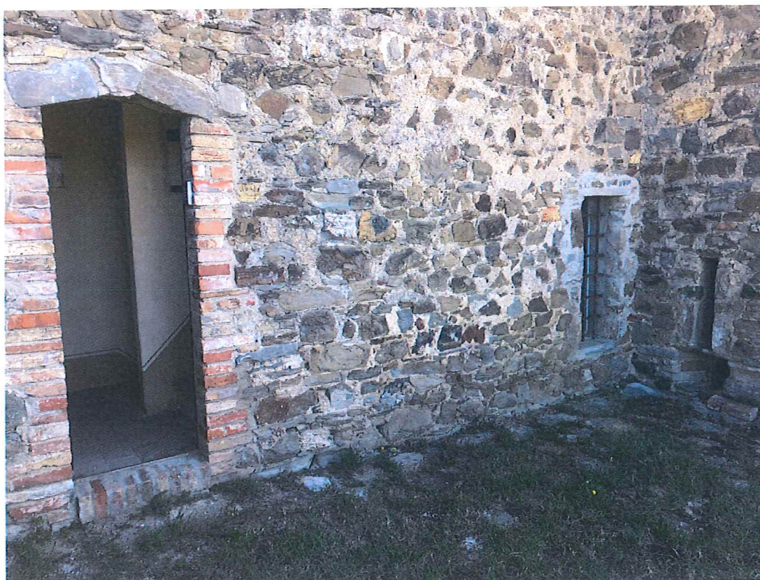
Foto n. 10 – Giardino e ingresso piano terra.
