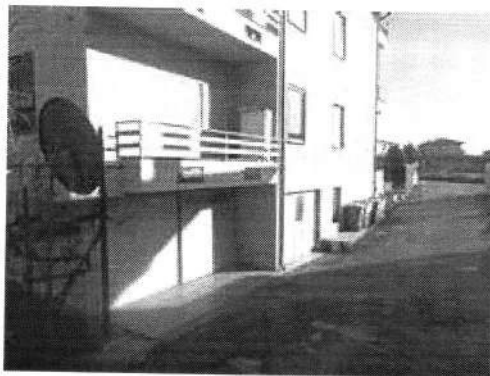
Foto Relativa alla Rampa che necessita per passare dalla via principale all'ingresso dell'Unità immobiliare interessata
