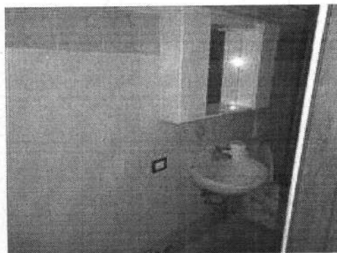
Piano Interrato con un Bagno realizzato al posto di una cantina
