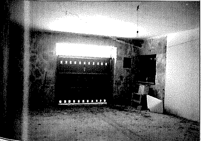
Fig. 17 - Il soggiorno al piano primo.
