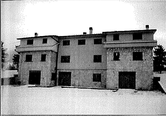
Fig. 7 - Il prospetto est del complesso immobiliare.
