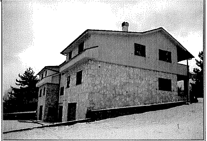
Fig. 8 - La villetta in oggetto è posizionata nella parte nord.
