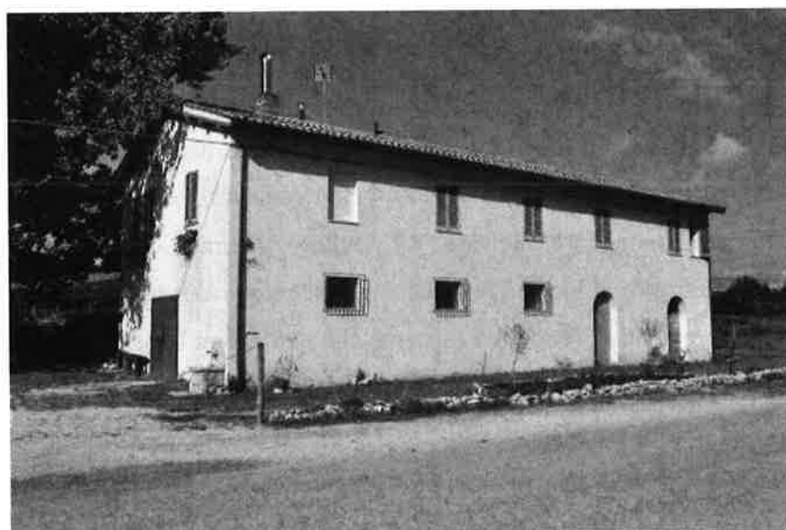
Prospetto lungo la strada
