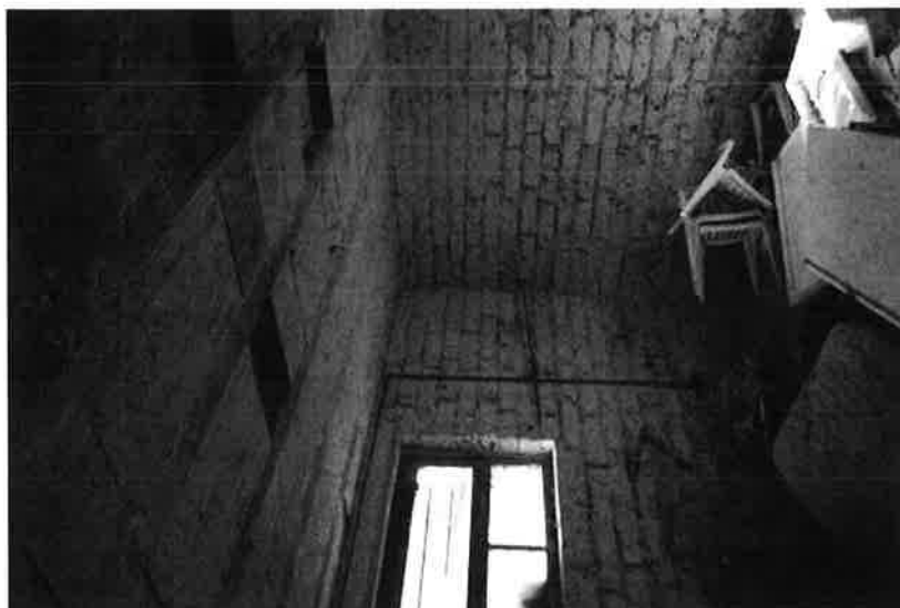
Edificio più recentemente
