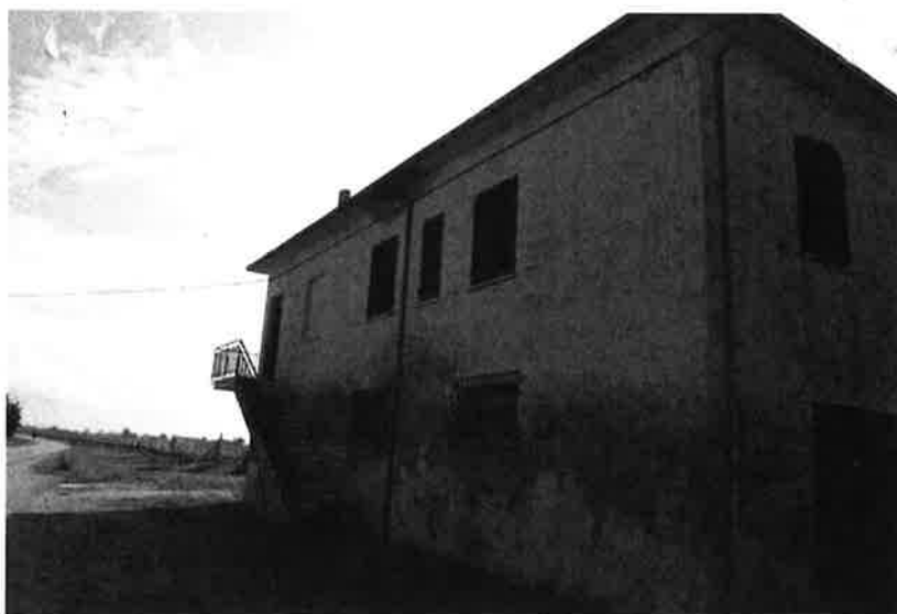
Prospetto lungo la strada
