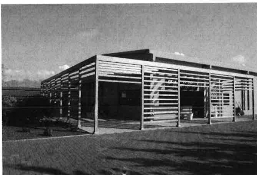
Edificio principale, angolo Nord-Ovest
