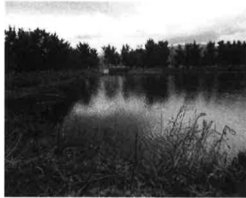
Bacino di decantazione
