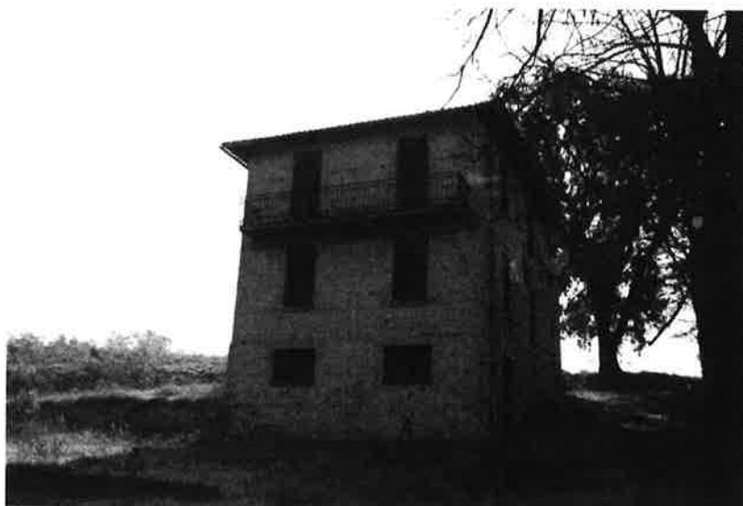
Edificio principale – prospetto di valle e laterale
