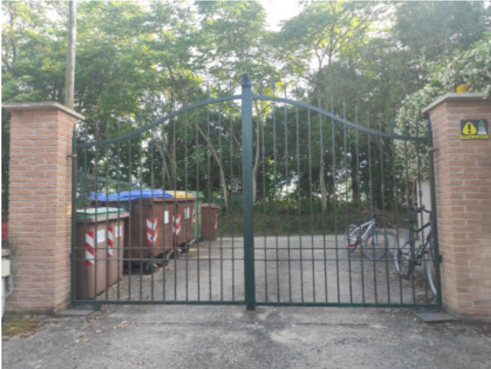
Foto n° 75: ingresso ai garage posto a destra del fabbricato posto in Deruta, Strada Esterna Vicinale del Moronaro n° 1
