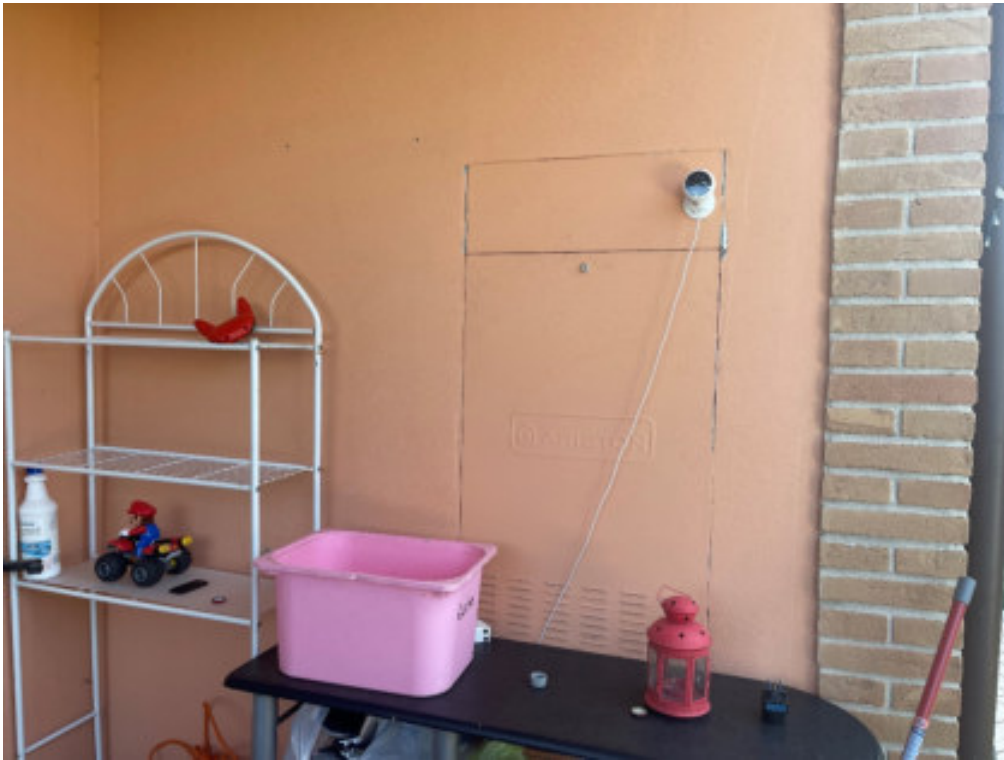
Foto n° 43: caldaia dell'unità immobiliare n° 1252/4-1256(graffata)
