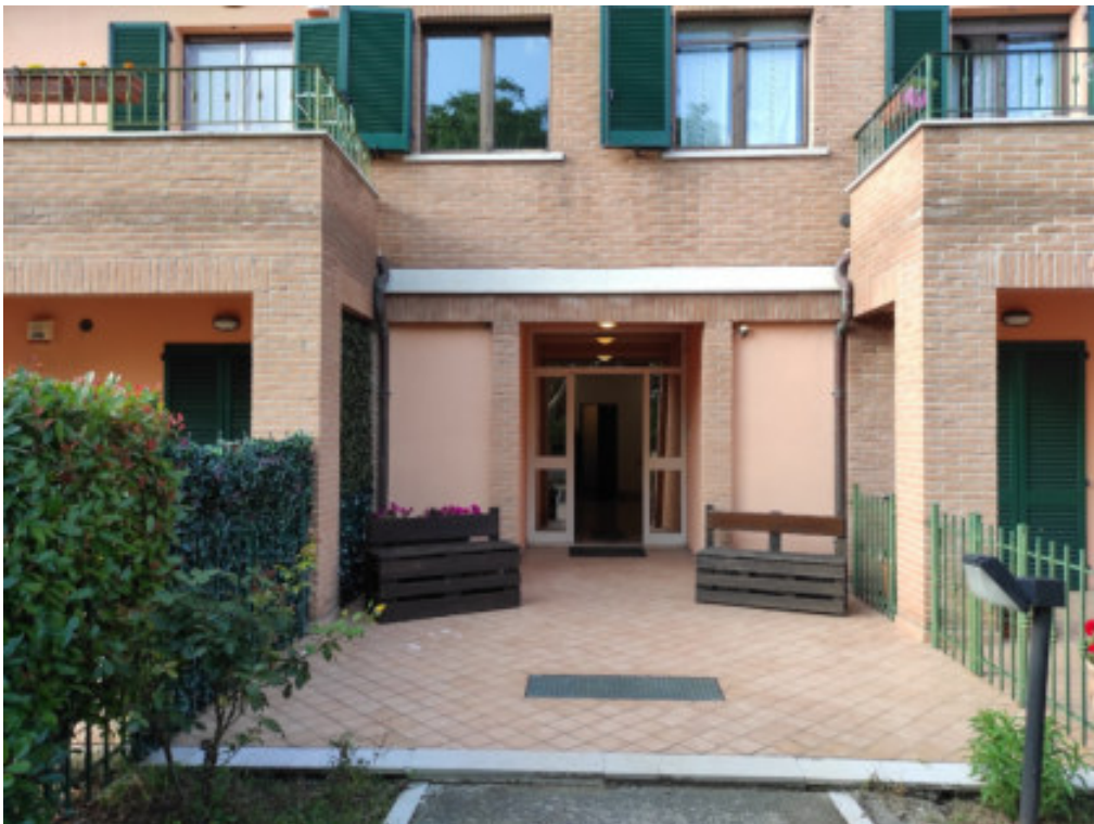
Foto n° 78: ingresso del fabbricato posto in Deruta, Strada Esterna Vicinale del Moronaro n° 1
