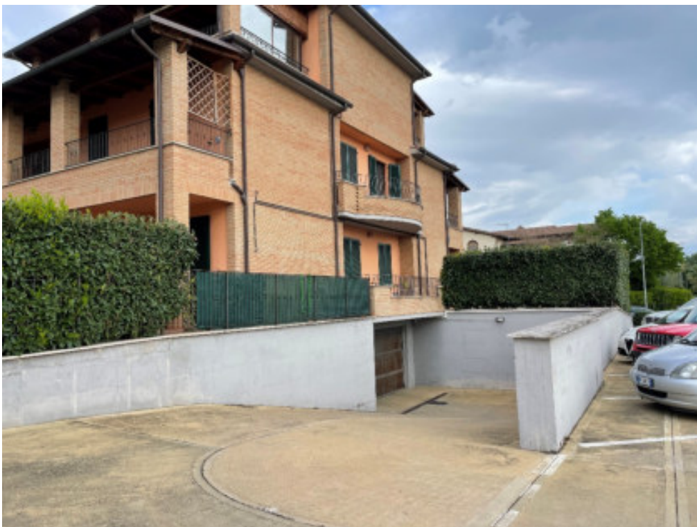
Foto n° 7: rampa di accesso ai garage del fabbricato posto in Deruta, Via della Speranza n° 6
