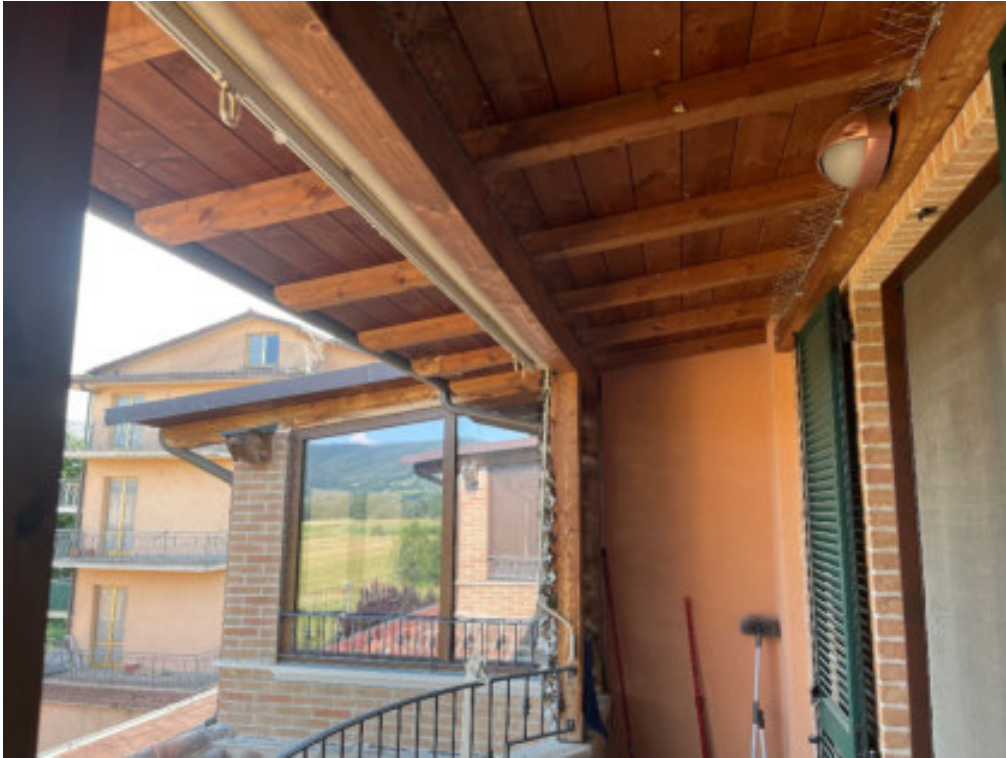
Foto n° 63: esterno dell'unità immobiliare n° 1252/10 – balcone coperto –
