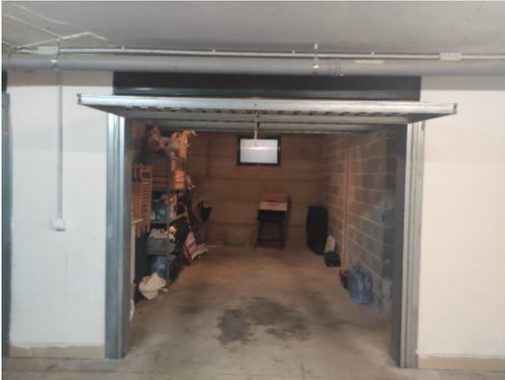
Foto n° 89: garage ( n° 1188/3 ) di pertinenza dell'unità immobiliare n° 1188/23
