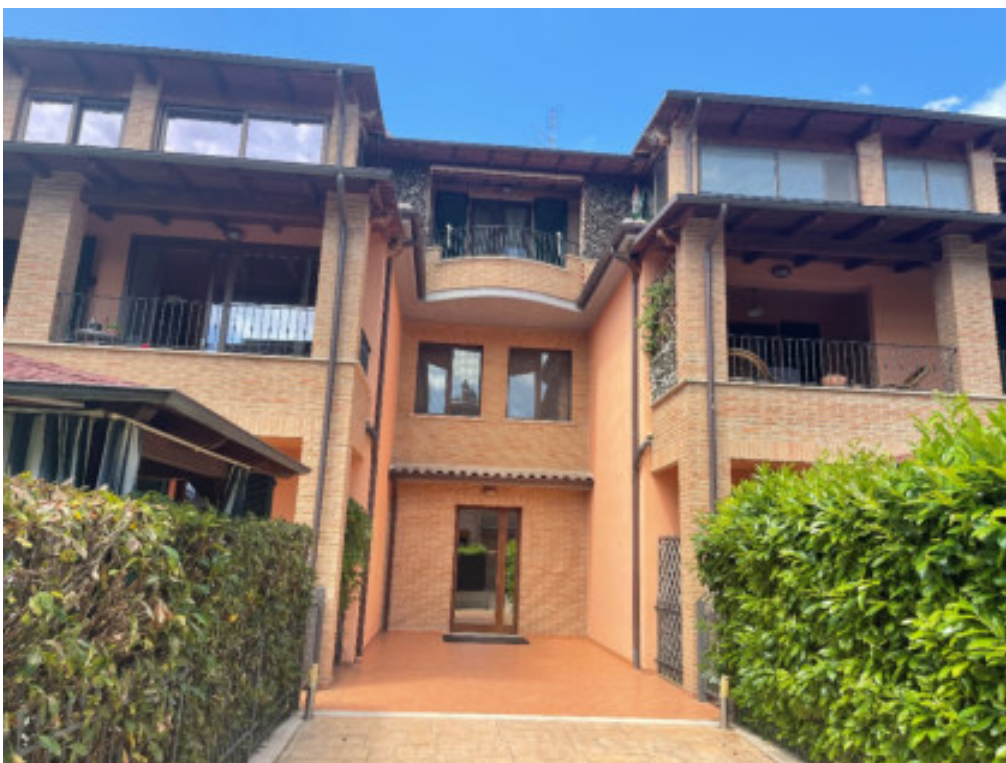
Foto n° 9: ingresso alle abitazioni del fabbricato posto in Deruta, Via della Speranza n° 6
