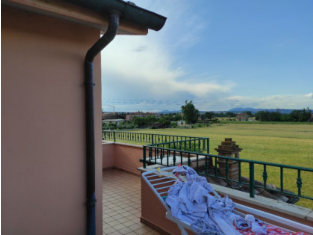
Foto n° 85: esterno dell'unità immobiliare n° 1188/23 – balcone –
