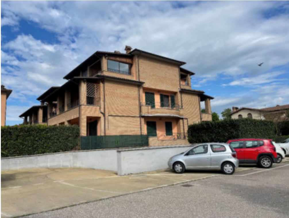
Foto n° 4: prospetto sud/est del fabbricato posto in Deruta, Via della Speranza n° 6
