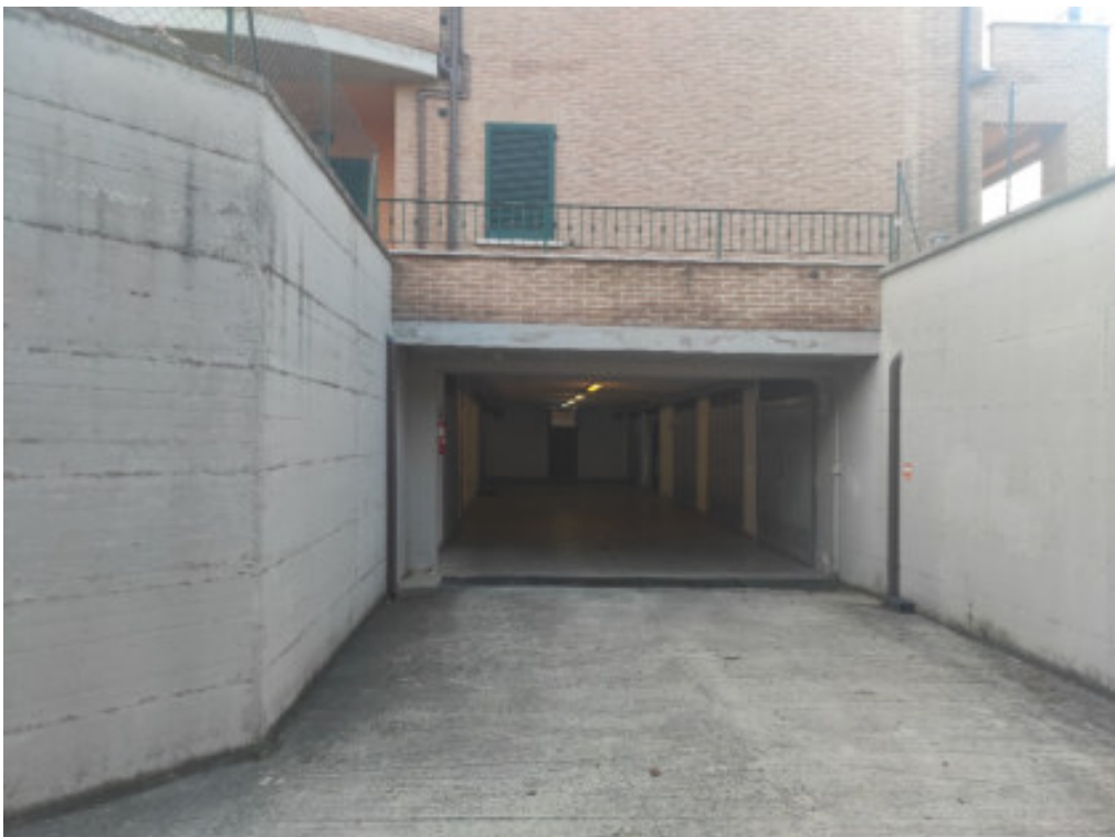
Foto n° 88: interno della corsia dei garages del fabbricato posto in Deruta, Strada Esterna Vicinale del Moronaro n° 1
