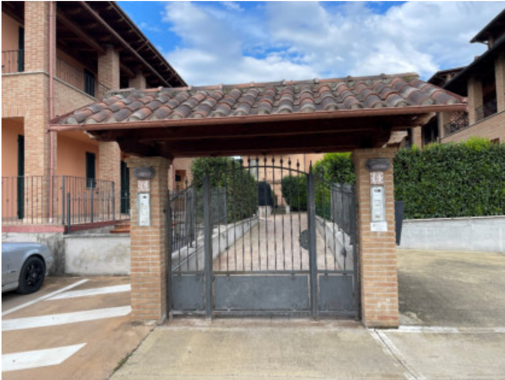
Foto n° 6: ingresso del fabbricato posto in Deruta, Via della Speranza n° 6 insistente sulla particella n° 1266 del foglio n° 9 del C.T. di Deruta
