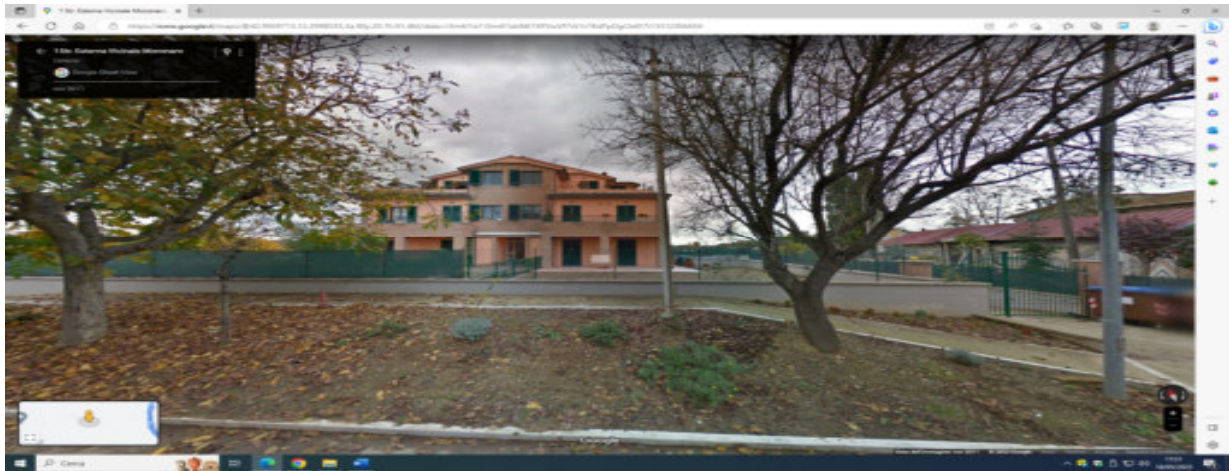
Foto n° 73: prospetto sud/ovest del fabbricato posto in Deruta, Strada Esterna Vicinale del Moronaro n° 1
