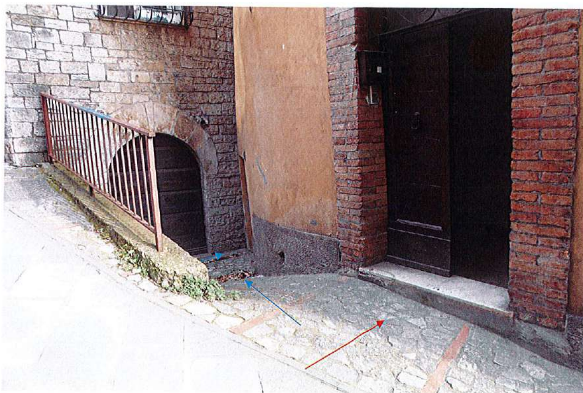
Portone di ingresso condominiale e accesso al piano sottostrada
