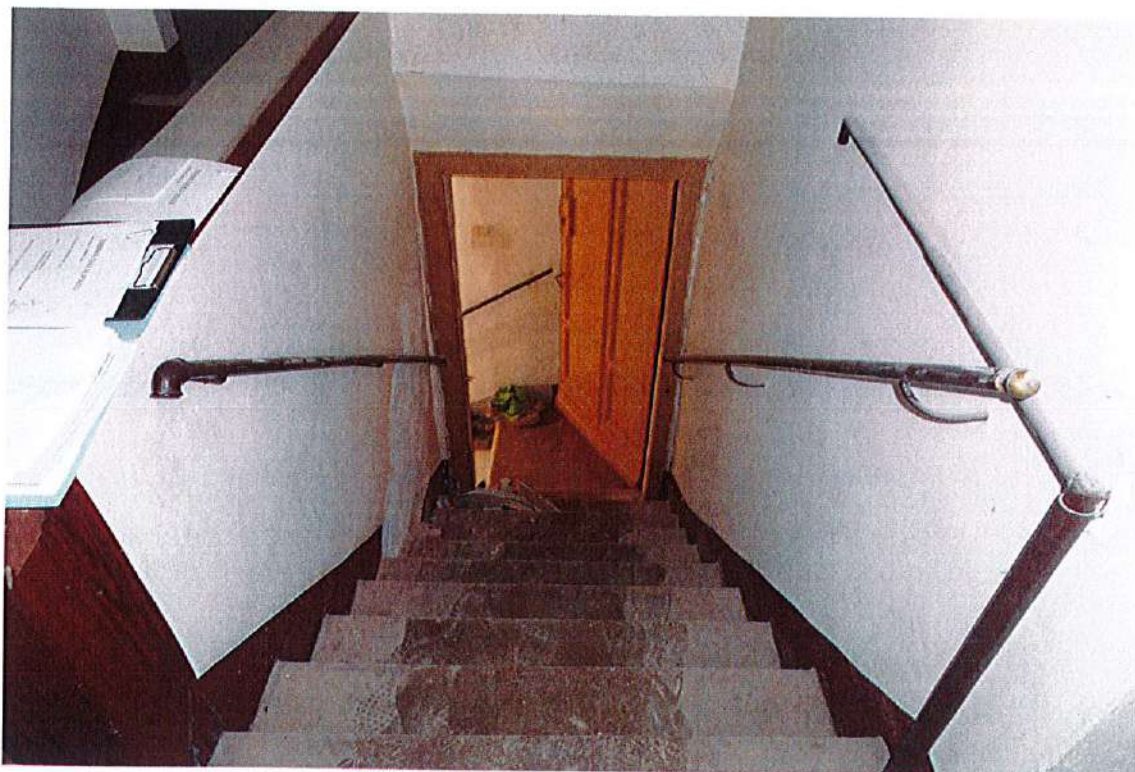
Rampa di scala interna esclusiva
