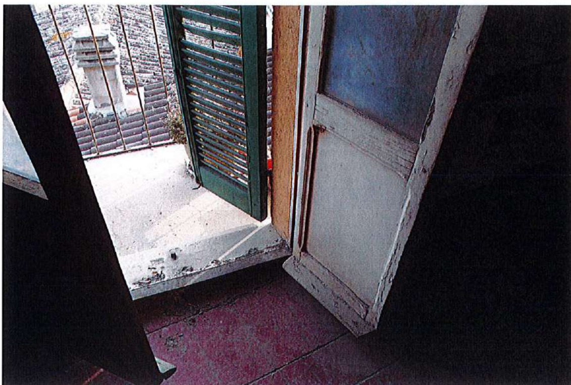
Particolare infisso esterno e particolare pavimento in cotto
