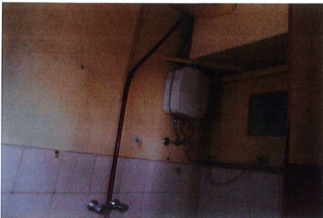
Particolare locale cottura
