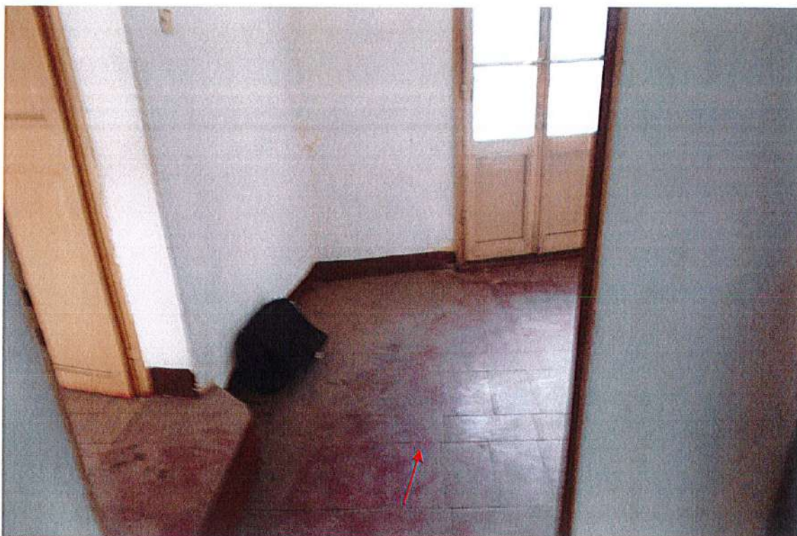
Accesso al vano n. 1 dal disimpegno di arrivo
