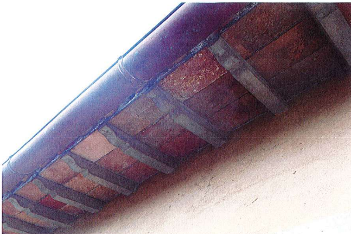
Particolare strutturale tetto (dall'esterno)
