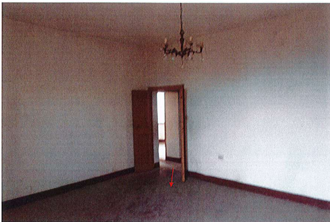
Vano n. 3 dal disimpegno
