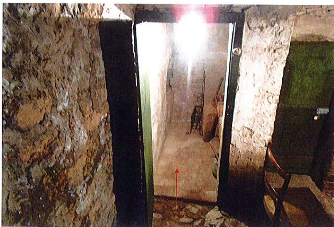
Disimpegno comune e accesso al locale fondo
