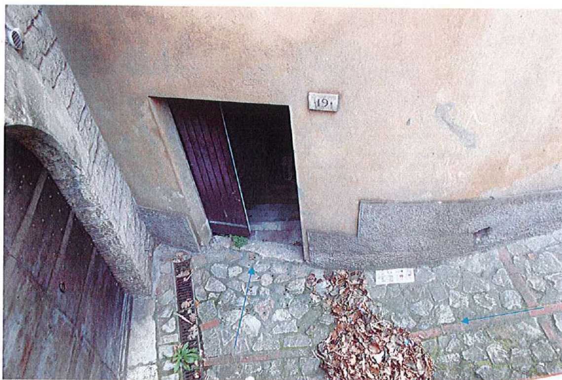
Accesso al piano sottostrada
