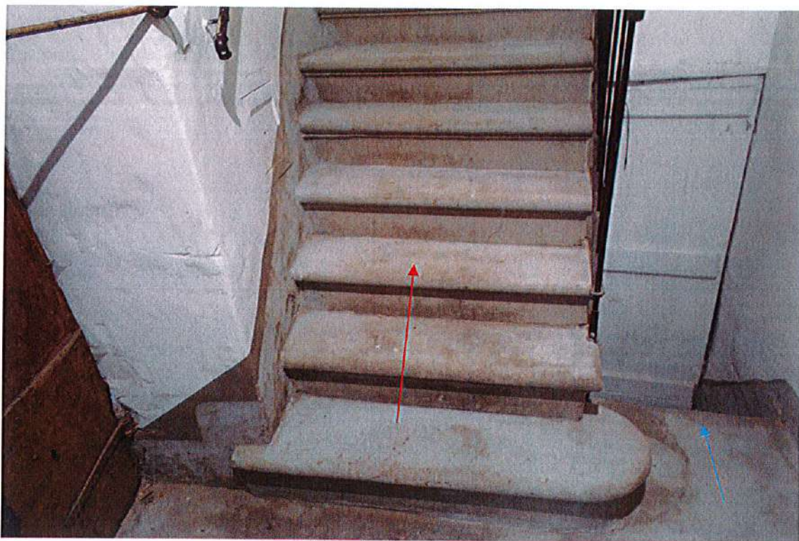
Androne interno con accessi: scala di collegamento ai piani - piano seminterrato
