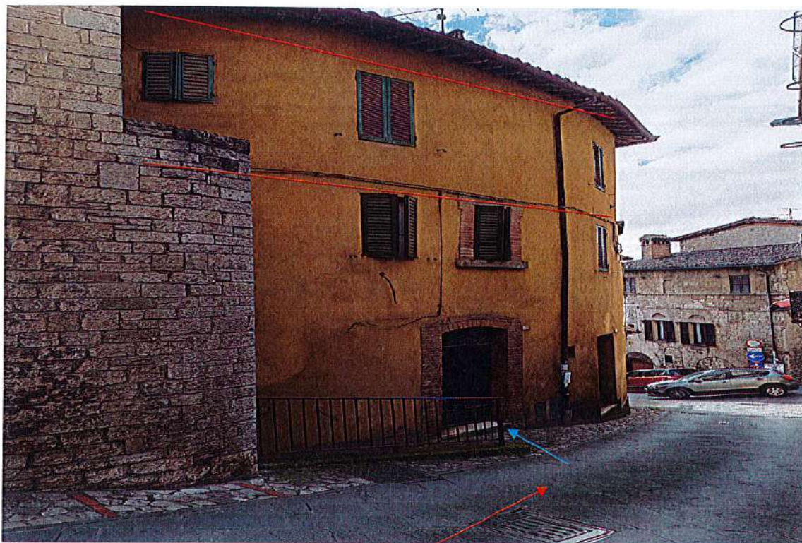
Vista fabbricato lato fronte con evidenziato l'appartamento piano 2° Portone ingresso condominiale
