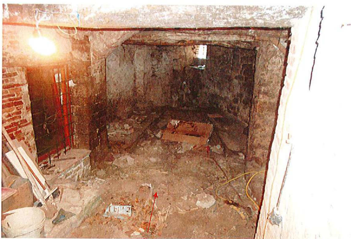
Locale legnaia dal disimpegno comune
