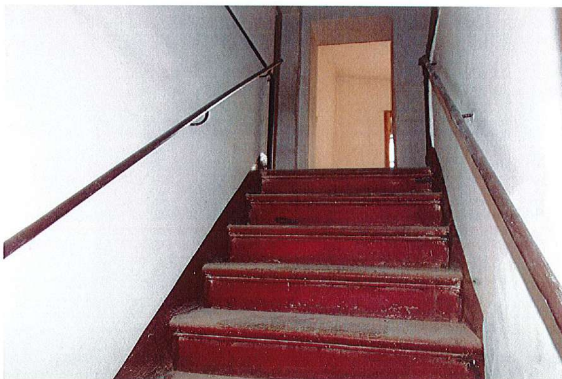
Rampa di scala interna esclusiva
