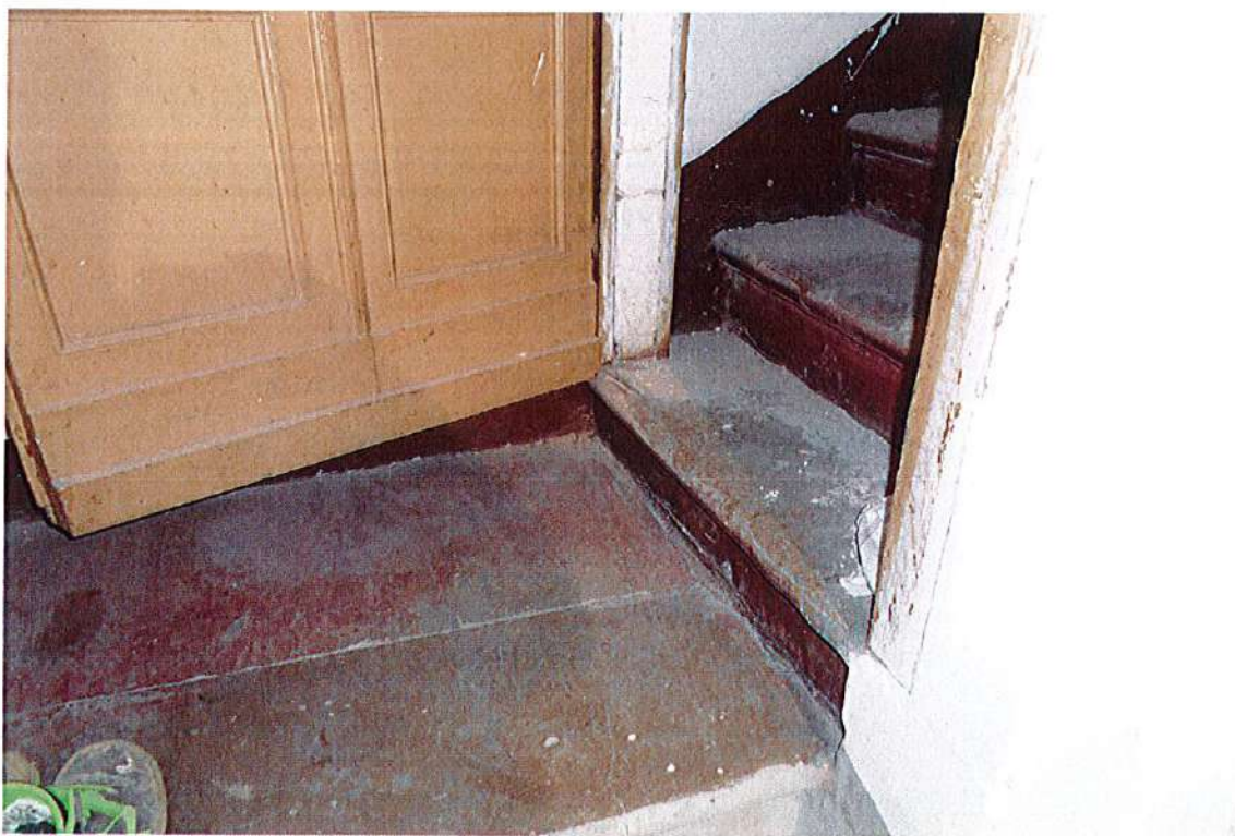
Portone di ingresso e scala esclusiva interna
